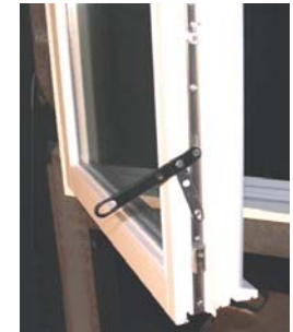
⑤ Gâche métallique de sécurité anti-décrochement et galet champignon
