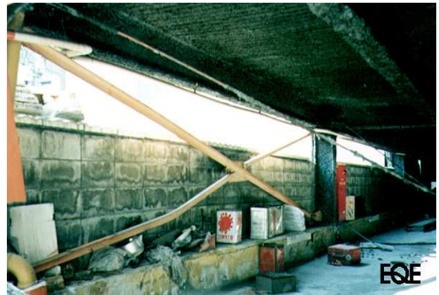
Figure 6-32 : Kobé 1995 – Instabilité des diagonales de contreventement.
