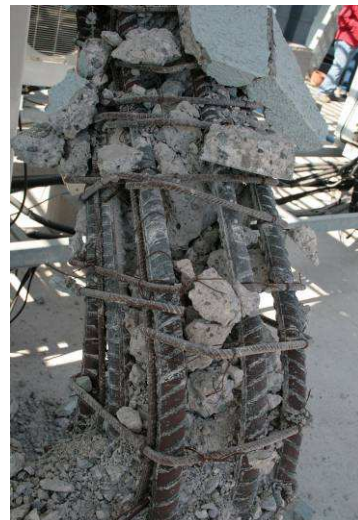
Figure 6-11 : Chili 2010 - Armatures transversales trop espacées et insuffisamment ancrées, pourcentage élevé des armatures longitudinales de diamètre important eu égard aux dimensions du poteau.
