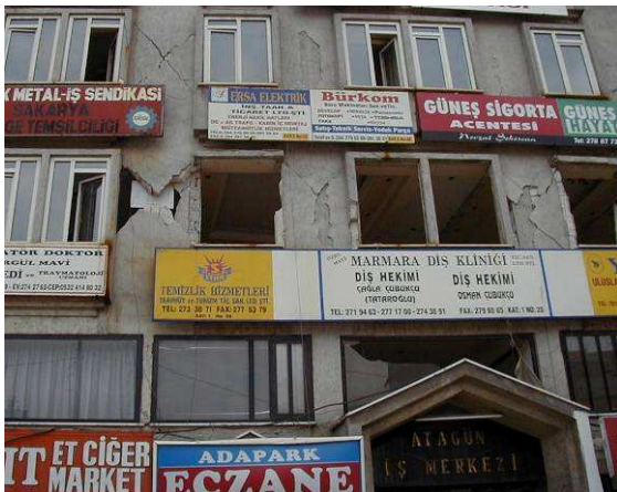
Figure 6-16 : Kocaeli 1999 - Ville d'Adaparazi, fissures de cisaillement au droit des trumeaux.
