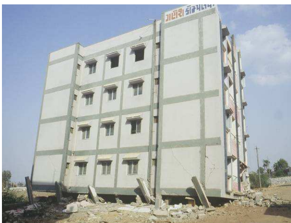
Le même type de dommage, à la suite des séismes de Bhuj 2001 (Inde) et de l'Aquila 2009 (Abruzzes, Italie)
