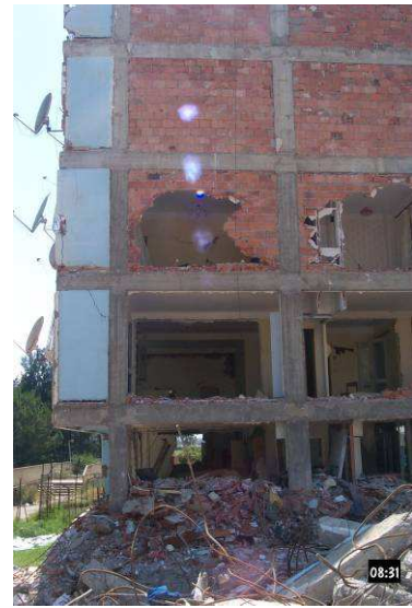
Figure 6-17 : Kocaeli 1999 - Panneaux sollicités perpendiculairement à leur plan.
