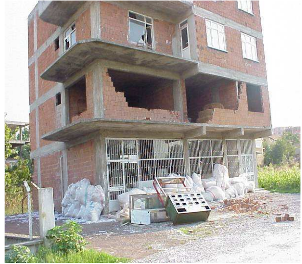
Figure 6-14 : L'Aquila 2009 - Bâtiments d'habitation R+3, fissures de cisaillement.
