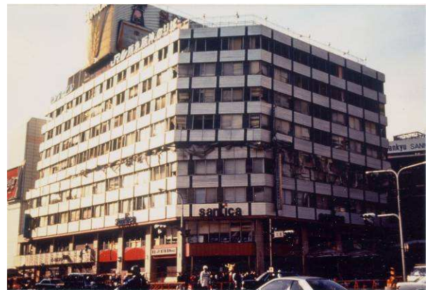
Figure 6-4 : Kobé 1999 – Rupture du 5 ème niveau
