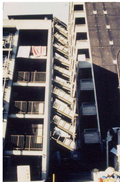
Figure 6-34 : Kobé 1995 – Interaction par des passerelles de liaison.
