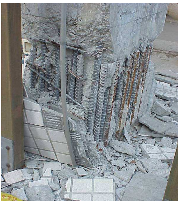
Figure 6-13: Chi-Chi 1999 – Manque de confinement transversal dans une zone de recouvrement à la base d'un poteau.
