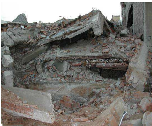
Figure 6-2 : Al-Hoceima 2004 – Effondrement généralisé du bâtiment.
