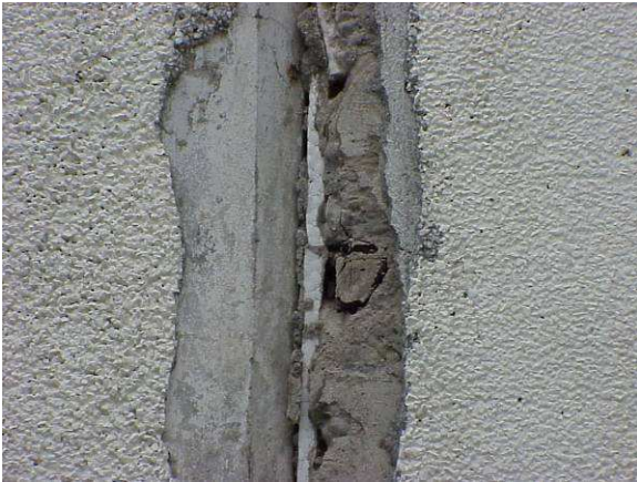
Figure 6-37 : Chi-Chi 1999 – Joint de faible ouverture rempli d'un matériau d'interposition.
