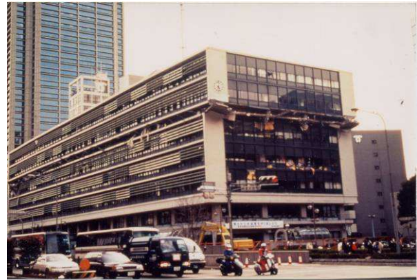
Figure 6-3 : Kobé 1999 – Mairie, rupture du 6 ème niveau
