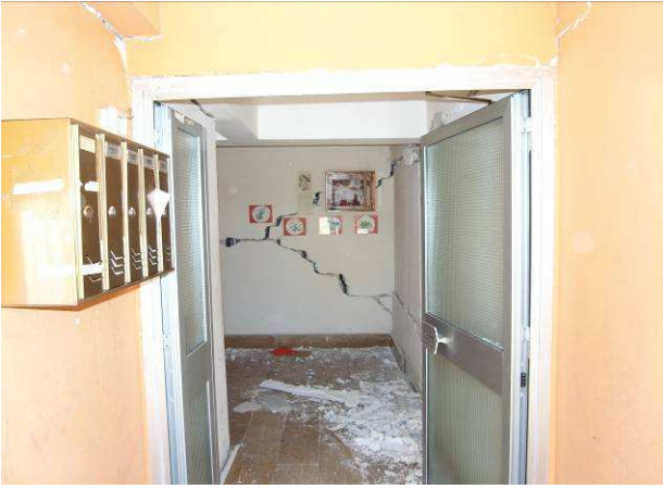
Figure 6-14 : L'Aquila 2009 - Bâtiments d'habitation R+3, fissures de cisaillement.
