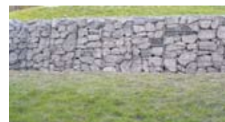
Muret en gabion de faible hauteur
