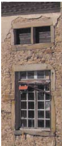
Détail de façade dont les encadrements sont en pierre, l'enduit traditionnel est à reprendre
