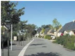
La voirie et les circulations piétonnes ombragées sont séparées par un caniveau en V
