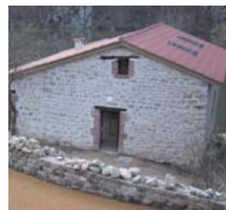
Création de deux ouvertures en toiture lors d'une réhabilitation (Les Echandes)
