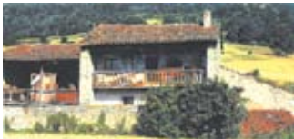
Ferme avec galerie, débord de toiture avec avancée de pignon
