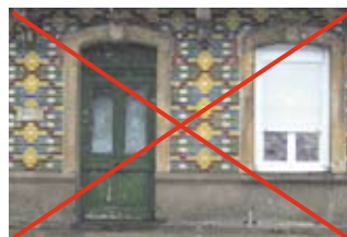
Exemple où l'harmonie de la façade est mis en danger par le choix de mauvais matériaux et couleurs de menuiseries de la fenêtre
