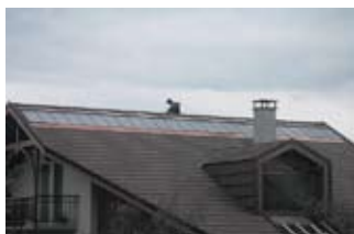
Panneaux solaires en bandes
