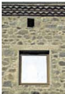
L'encadrement béton est enduit soigneusement. Il disparaît dans la maçonnerie rejointoyée.
