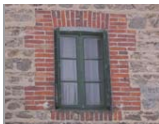
Menuiserie bois, fenêtre à deux vantaux de trois vitres, encadrement brique
