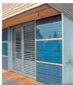
Forme d'habitat contemporaine conçue pour intégrer les panneaux solaires, ils remplacent une partie du bâti
