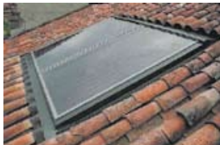
Panneaux solaires encastrés dans le plan de toiture
