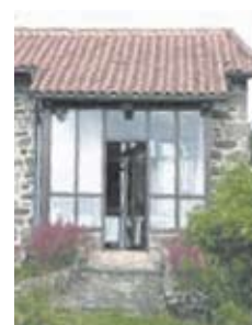
Baie vitrée sur façade arrière
