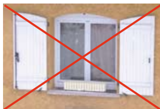
Volets cintrés en PVC blanc avec ferrure apparente, aspect artificiel
