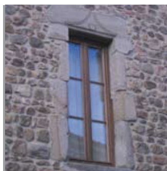
Menuiserie bois, fenêtre à deux vantaux de trois vitres, encadrement pierre
