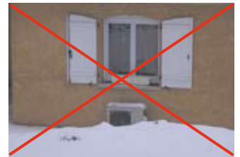
VMC en applique trop visible depuis l'espace public
