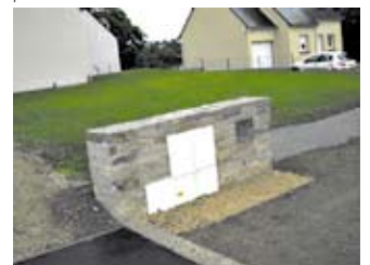
Coffrets intégrés dans une murette en pierre
