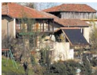
Panneaux solaires sur avant
