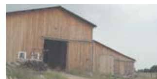
Pans recoupés et bardage bois, Saint-Maurice-en-Gourgois
