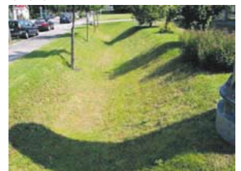
Noue de collecte des eaux de pluie
