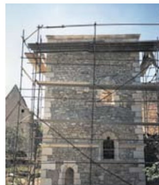
Construction neuve en pierre
