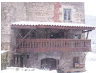
Balcon en saillie soutenue par des avancées de poutre, avec rambarde à motifs
