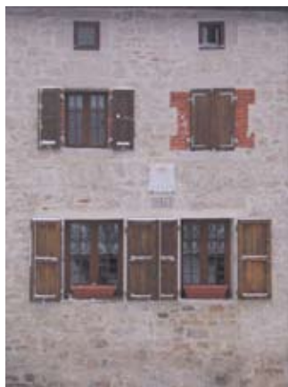
Maison de bourg : symétrie des ouvertures et décroissance verticale
