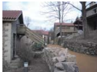
Accès revêtu de graviers
