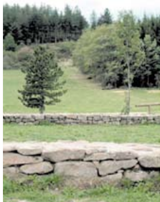
Murets autour d'Essalois
