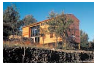
Construction bois. Le mur de soutènement en pierre sèche a été conservé. Les baies ne sont pas orientées sur le grand paysage.
