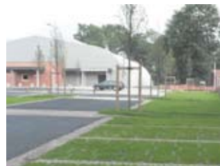
Combinaison pavés et gazon pour parking végétalisé drainant
