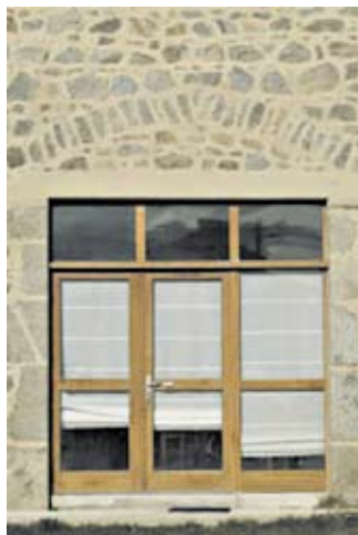
Rénovation d'une porte de grange
