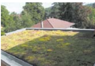
Toiture terrasse végétalisée
