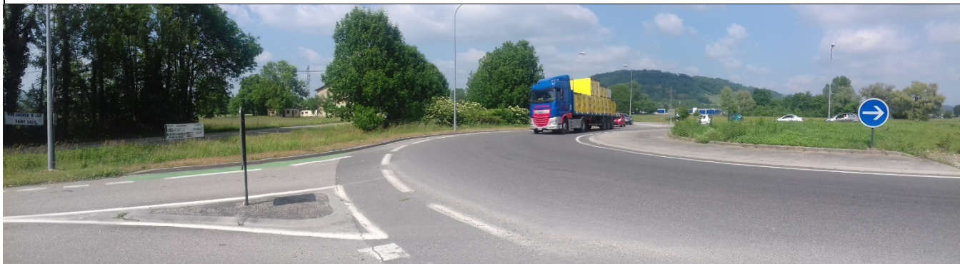
Photo 2 : Vue sur le giratoire actuel depuis le Sud-Ouest
