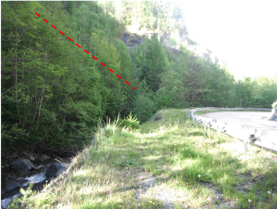
Vue 5 : Passage de la conduite en rive gauche de la Salse juste avant son passage en aérien
