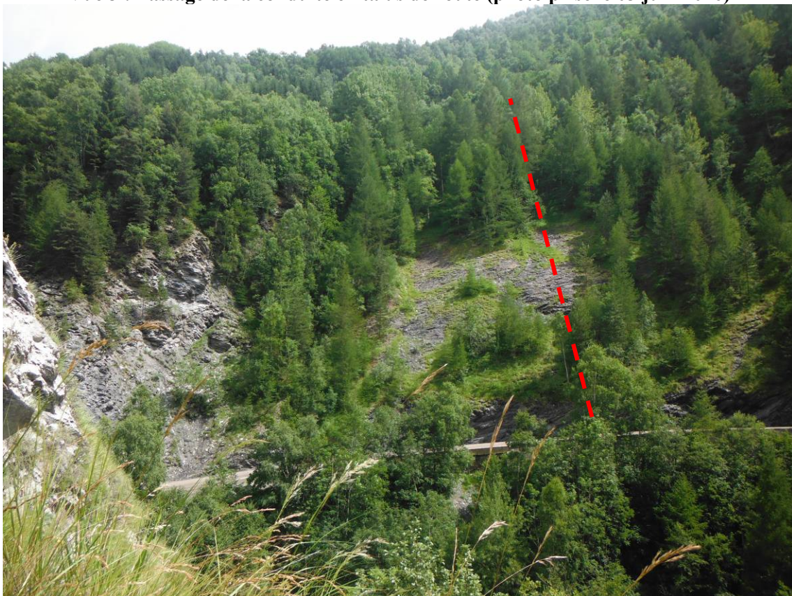
Vue 4 : Passage de la conduite forcée en amont de la route partie basse (juillet 2016)
