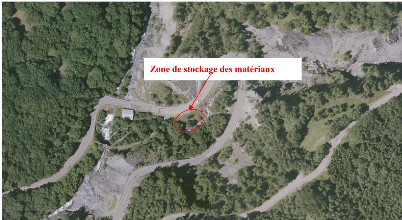
Figure 13 : Zone de stockage des matériaux
