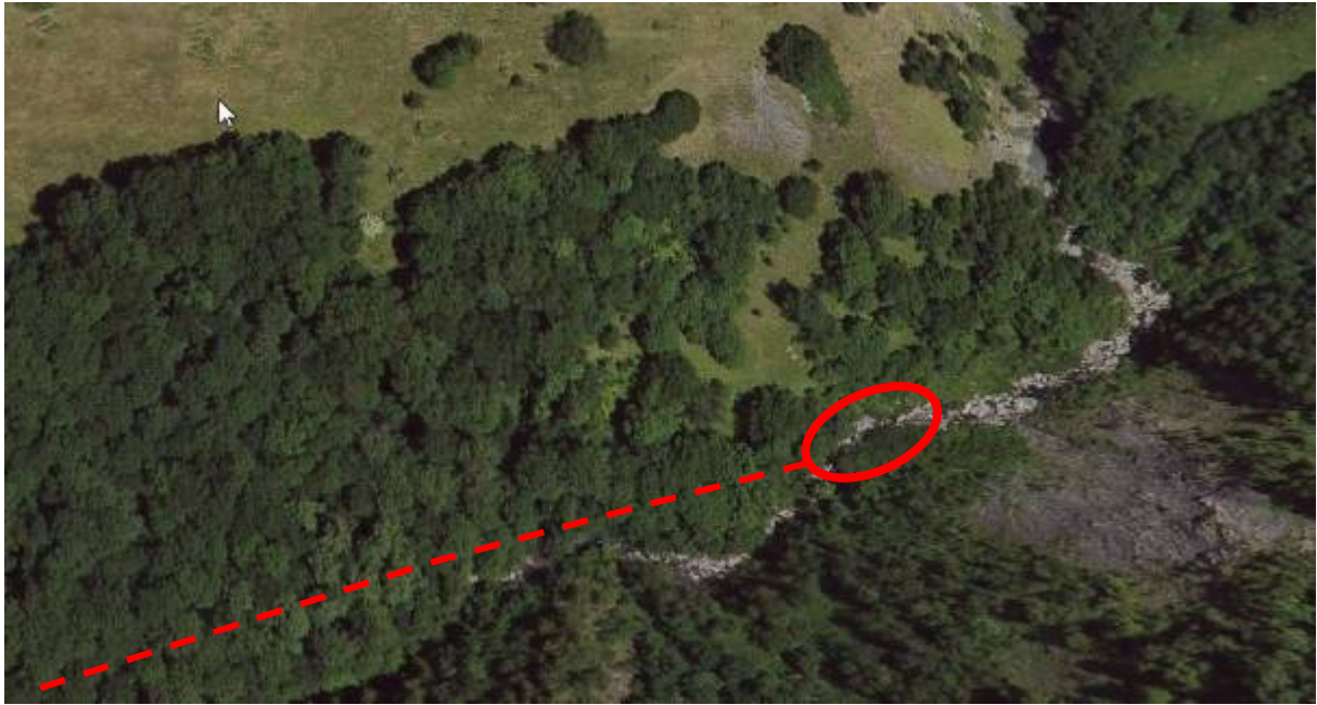
Vue 1 : Emplacement de la prise d'eau et passage de la conduite forcée sur sa partie amont
