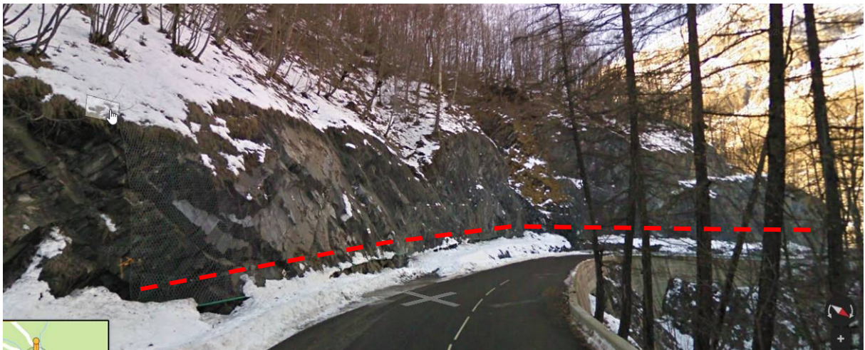
Vue 2 : Passage de la conduite le long de la route (photo Google maps décembre 2009)
