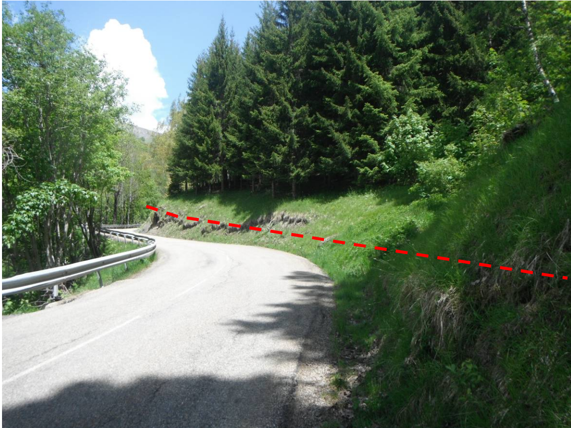
Vue 3 : Passage de la conduite en talus de route (photo prise le 03 juin 2016)
