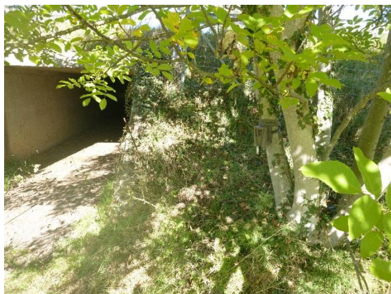
Photo 13 Localisation du piège photo 1
