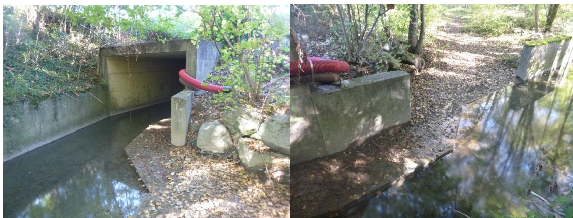
Photo 16 Entrée Sud du passage sous A410
