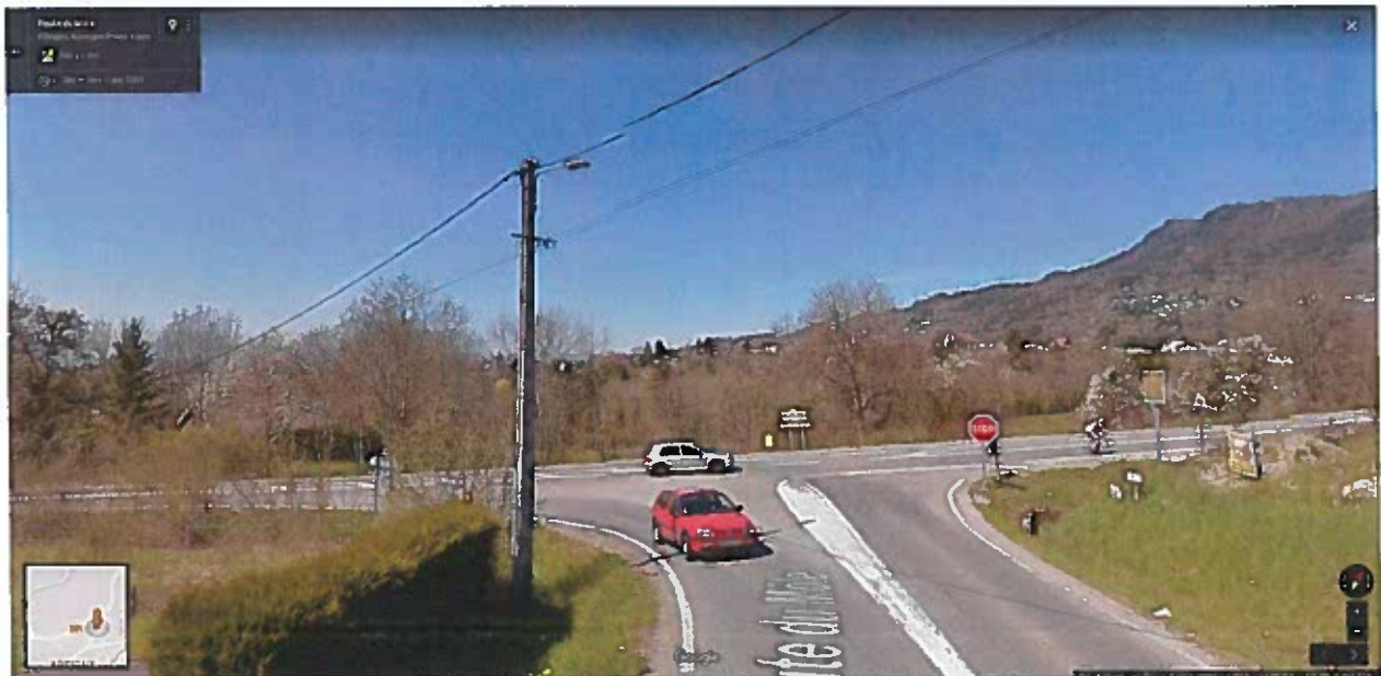
PHOTO 6 – Route du Môle (RD9) et carrefour avec RD 20 (en venant du lieudit Arpigny)
