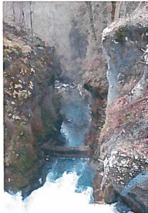
Figure 9 : vue à l'aval immédiat du barrage
