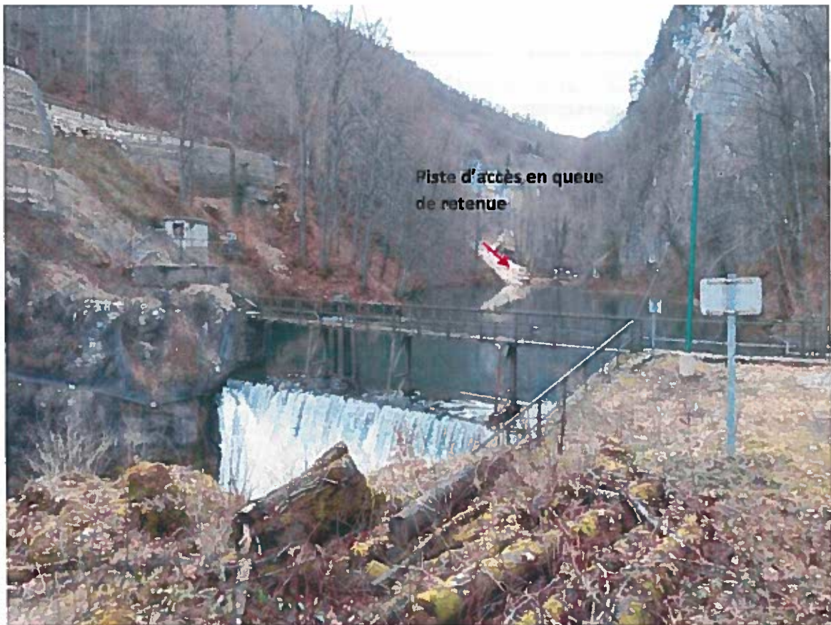
Figure 5: Vue d'ensemble depuis la rive gauche en aval du barrage (18/01/2018)
