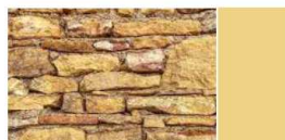
PIERRES DORÉES murets de soutènement
