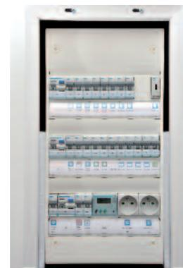
Colmatez les points de passage de **l'ensemble des équipements électriques** dans le local : tableau électrique, encastrement des boîtiers d'interrupteurs ou prises de courant, sorties vers les points lumineux, sorties des câbles en extrémités de gaines. Préférez des boîtiers étanches.
