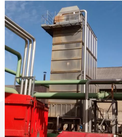
IRDEFA sur le circuit de refroidissement du four FARC
