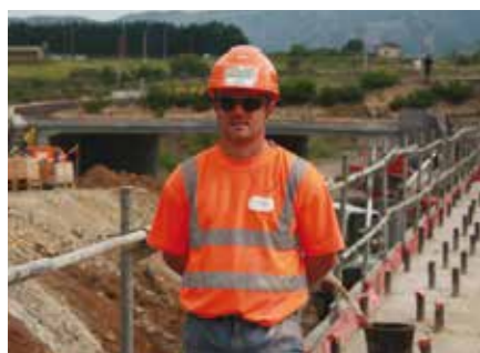
Stéphane SAGNARD sur le chantier de la tranchée couverte
