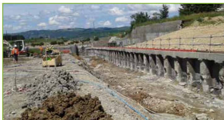
La construction de la paroi lutécienne tirantée.
