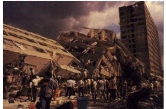
**Illustration du phénomène de résonance:** à proximité d'un bâtiment de 10 étages intact, un bâtiment d'une vingtaine d'étages a été complètement détruit lors du séisme de Mexico (1985), dû à un effet de site important.
