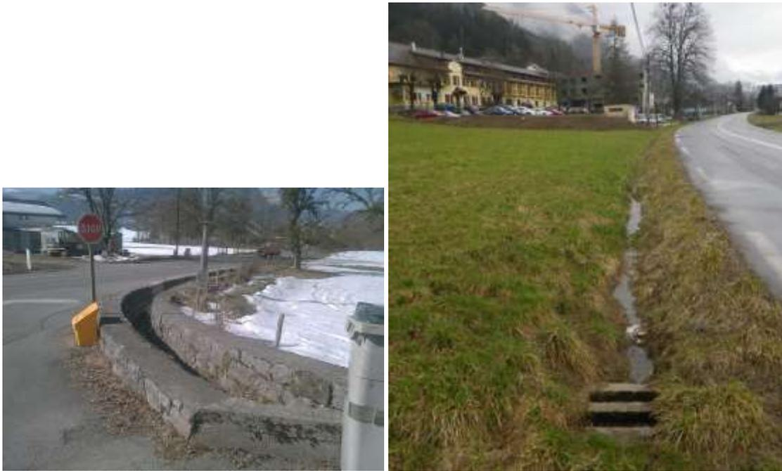
**Figure 4 : Photo des ouvrages existants (à gauche, ruisseau de chessin. A droite, Buse en traversée de la RD 907 coté EHPAD)**
