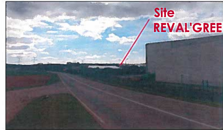
N°2 - Vue vers le Sud-Ouest ▼ (20/03/2017)
