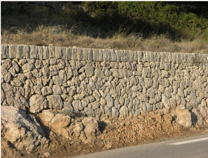
Mur de soutènement de talus
