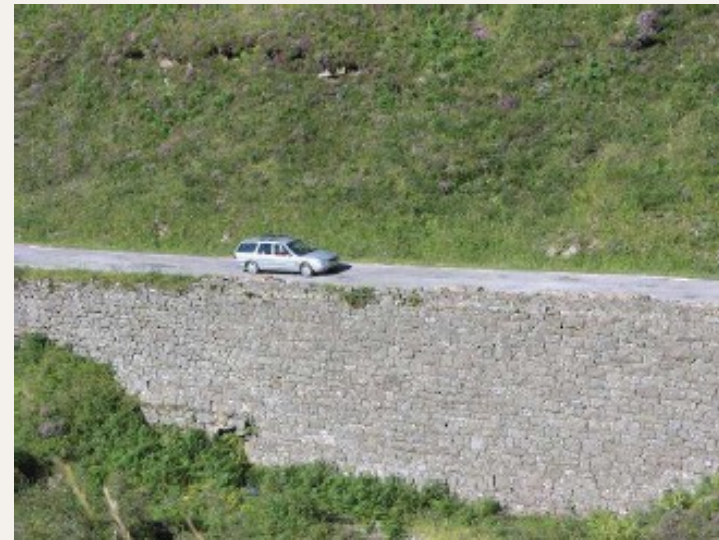
Mur de soutènement routier
