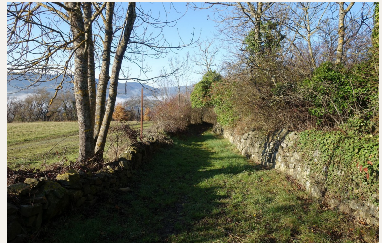
Murs de soutènement de terrains agricoles bordant un sentier
