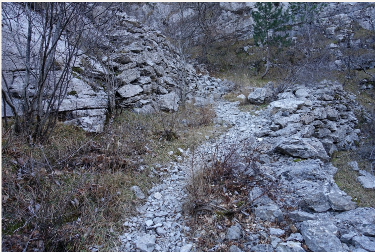
Murs de soutènement de sentiers de randonnée
