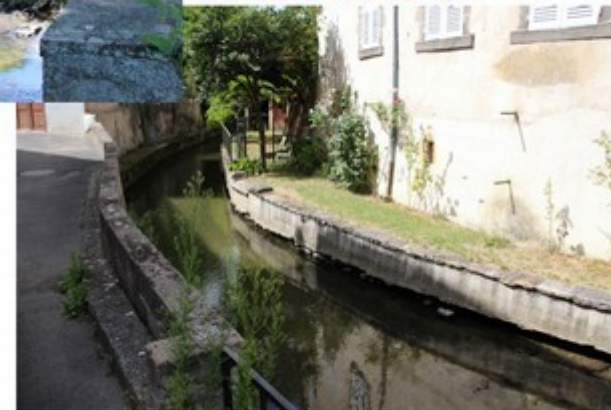
Très mauvais état
