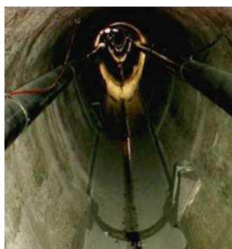
Échangeur installé dans un ovoïde existant (Rabtherm), échangeur pour collecteur existant (Uhrig) (Lyonnaise des Eaux)
