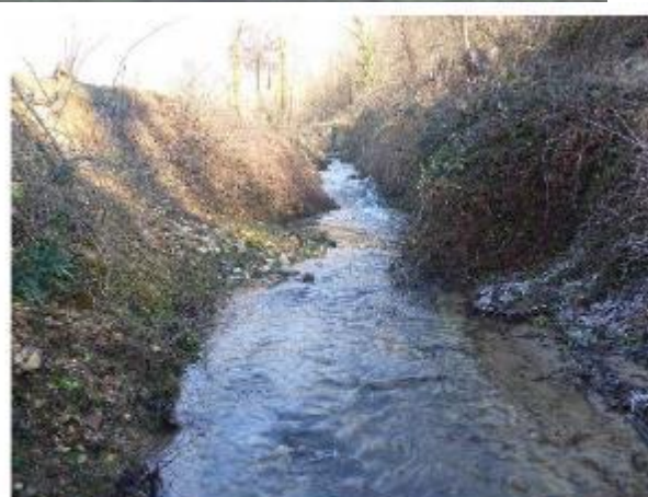
Limite aval de l'affleurement de 30 m sur le substratum molassique (obstacle à la continuité piscicole)
