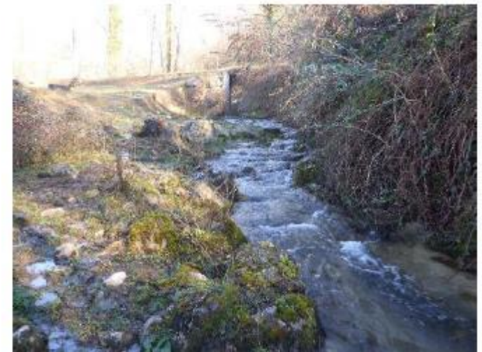
Radier en aval de la fosse de dissipation du pont 1 (obstacle à la continuité piscicole)
