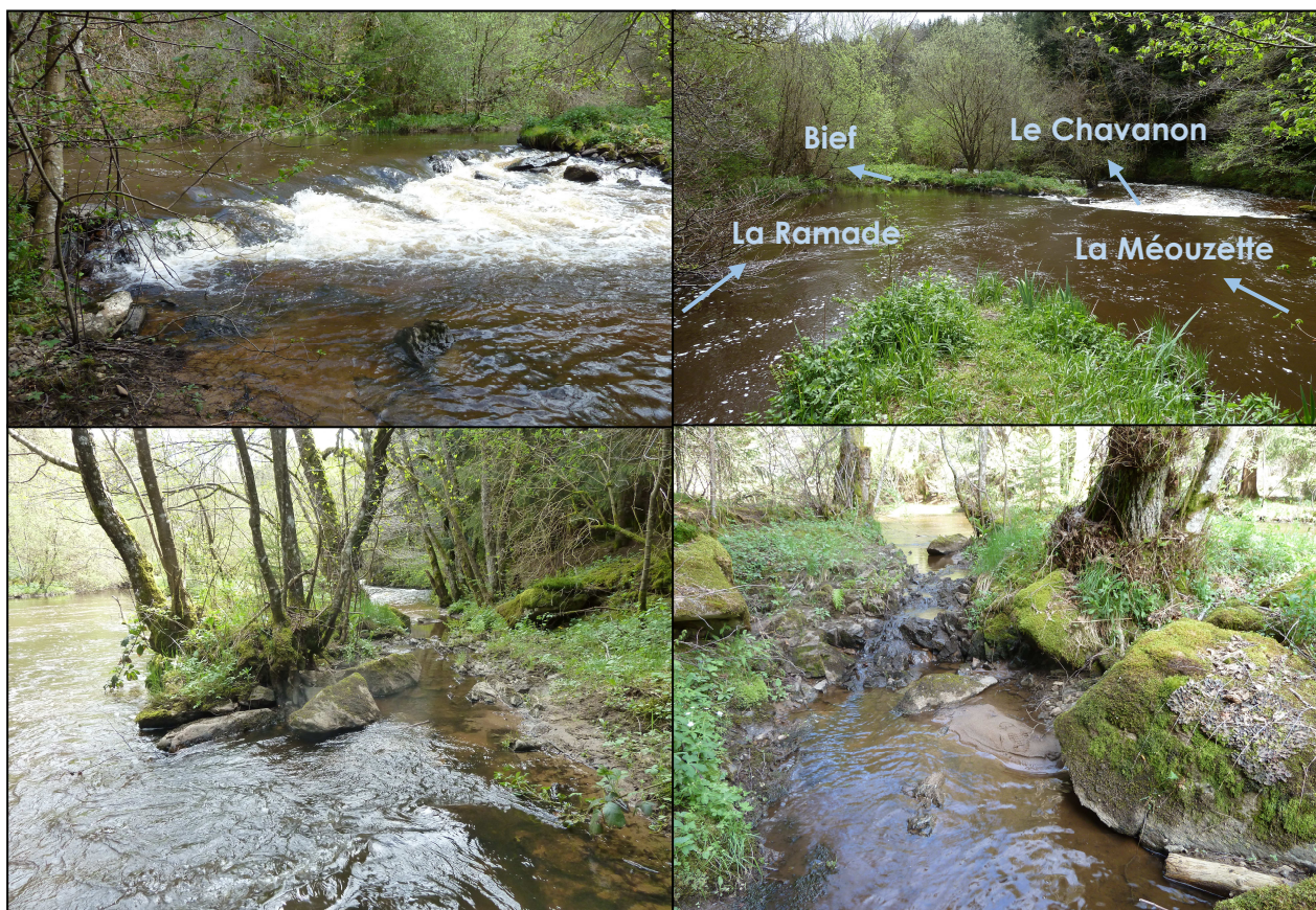
Figure 2 Vue générale de l'ouvrage transversal (images du haut), et des retenues d'eau et flux concernés, puis du chenal de crue existant côté droit du seuil – (Clichés BIOTEC - mai 2015).
