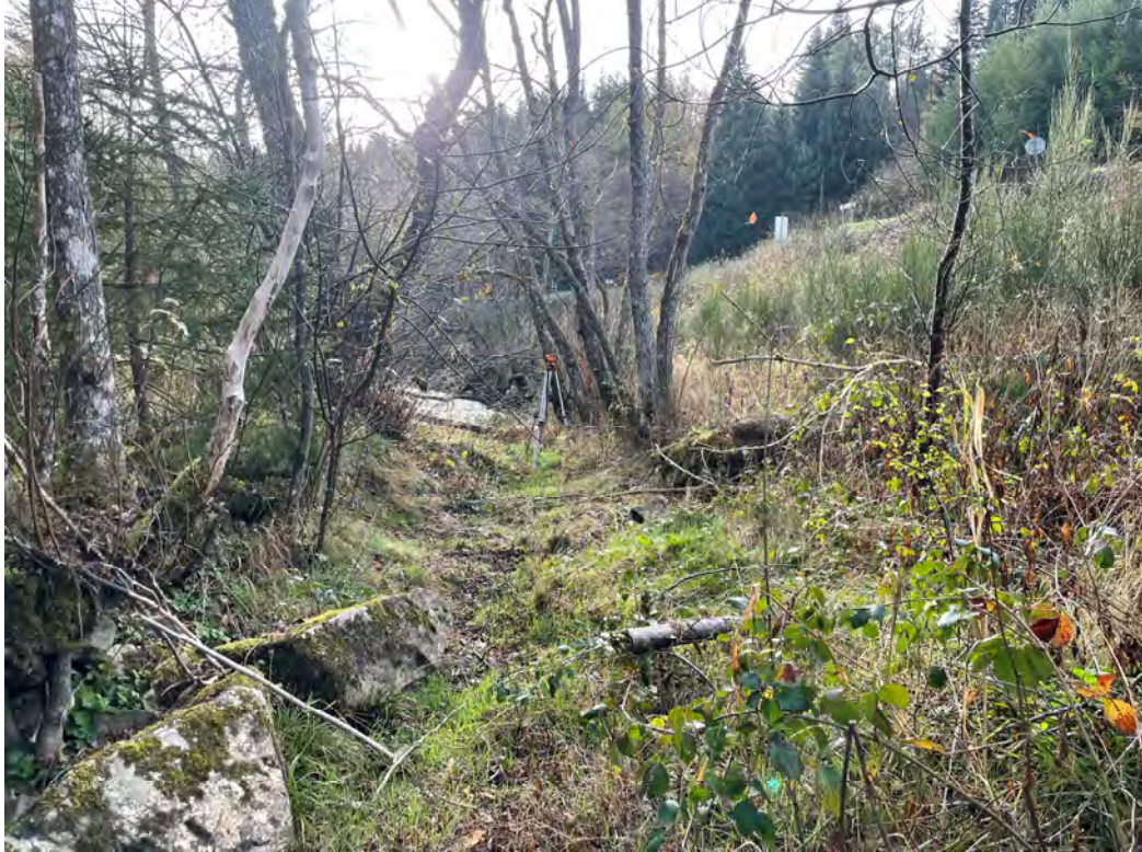
Photo 2 : Bras de décharge en rive droite
