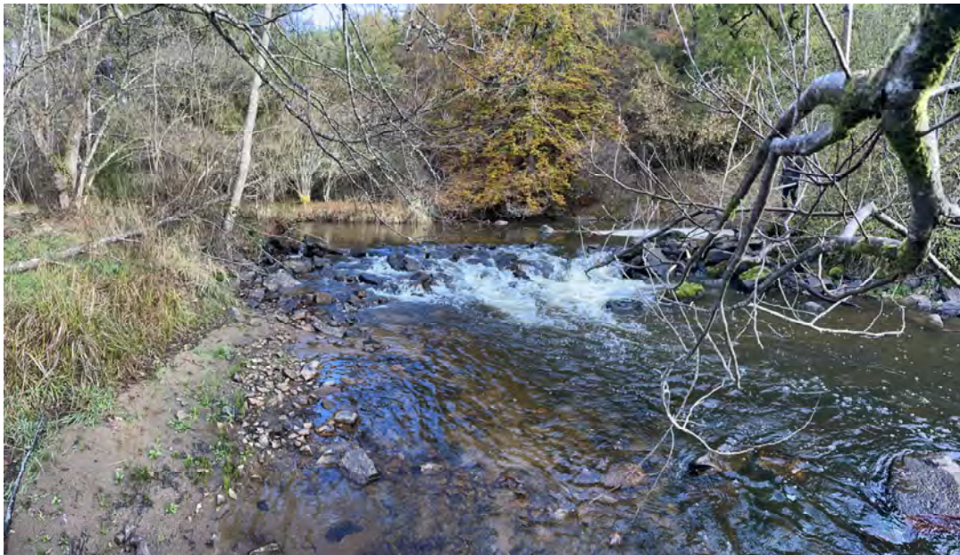
Photo 1 : Seuil de prise d'eau
