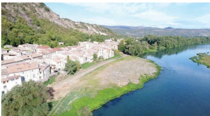
Cliché 13 – Vue du bourg de Baix et du Vieux-Rhône vers l'amont
