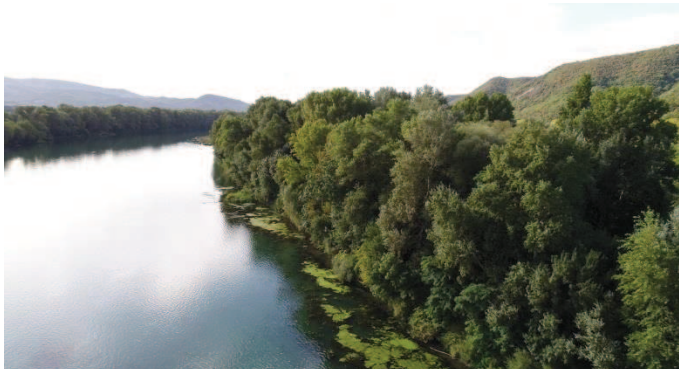
Cliché 1 – Vue de la digue démantelée (vue vers l'aval), 2017
