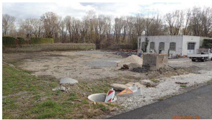
Cliché 6 – Zone d'installation de chantier (Base-vie et aire de retournement des engins)
