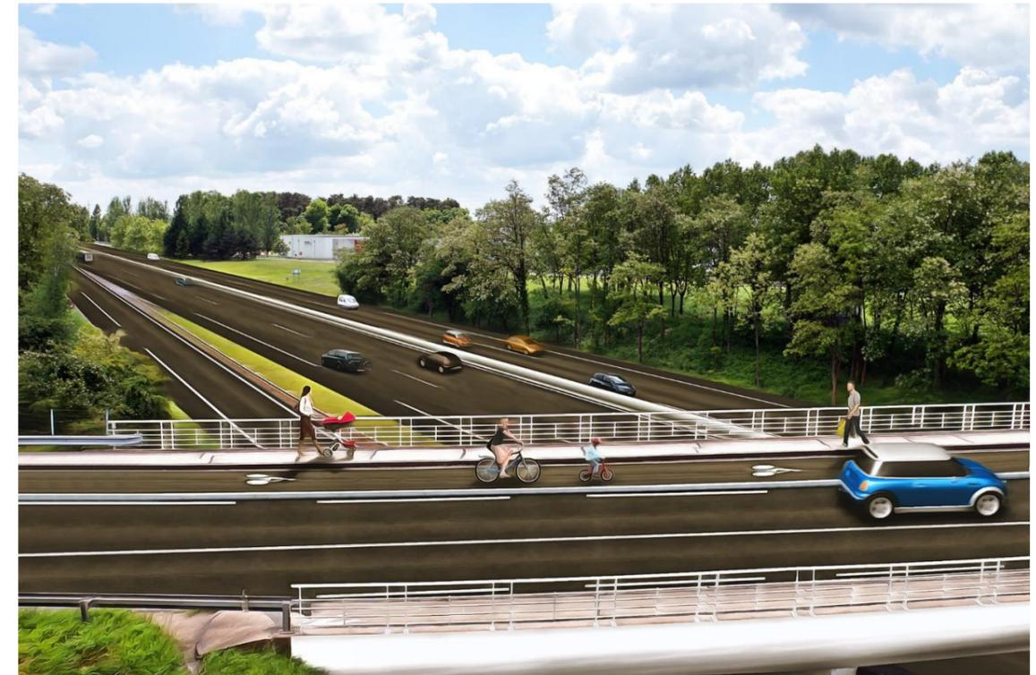
Figure 42 : Image de référence d'un autre projet avec intégration de modes doux sur un ouvrage de franchissement d'une voie rapide.
