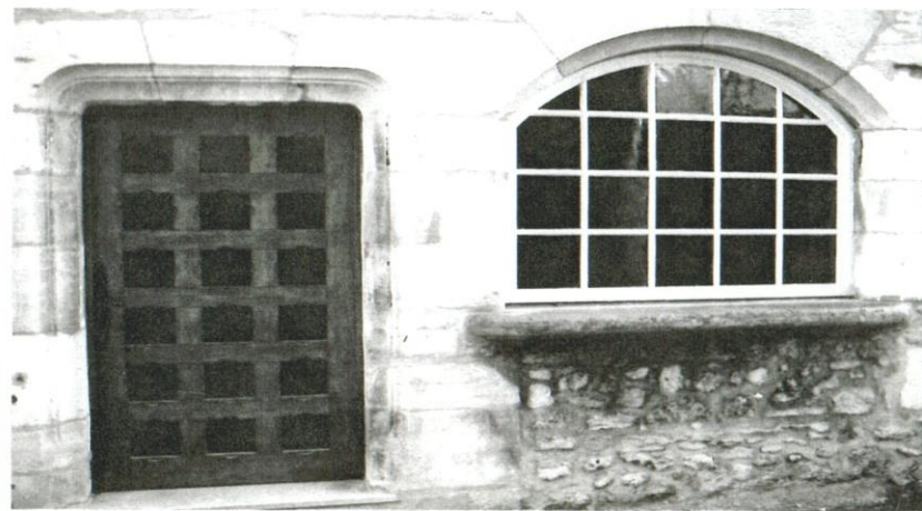
LINTEAU EN PLATE-BANDE ET ARC SURBAISSE MOULURES
