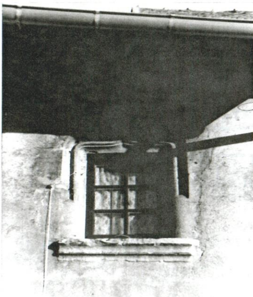
LINTEAU EN ACCOLADE
