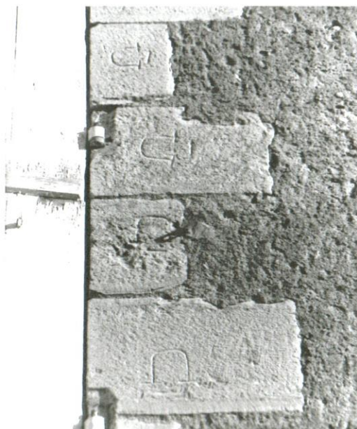
ENDUIT A PIERRE VUE
