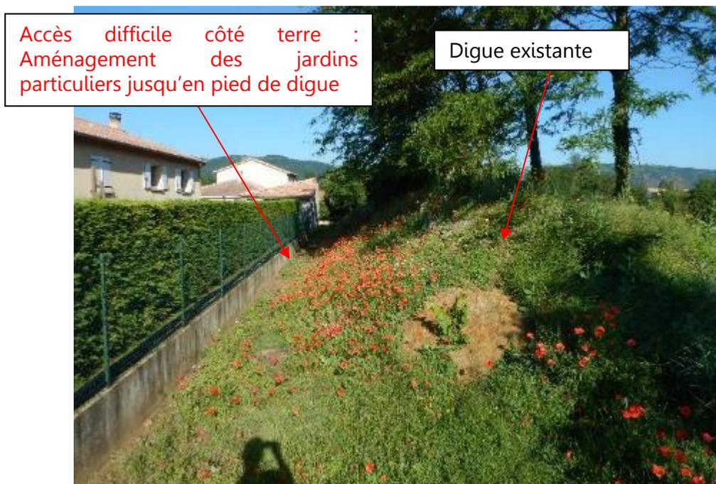
Figure 3 : Digue existante coté Val - Vue en direction de l'aval depuis la pointe amont de la digue
