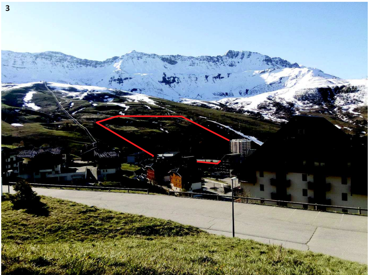
Photo prise depuis la route desservant les habitations du plan du Mollaret (Photo transmise par la mairie, 2017)
