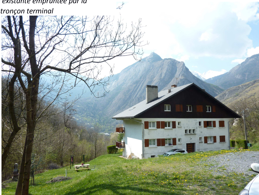
Illustration 10: habitation la plus proche de la centrale, à une cinquantaine de mètres en aval
