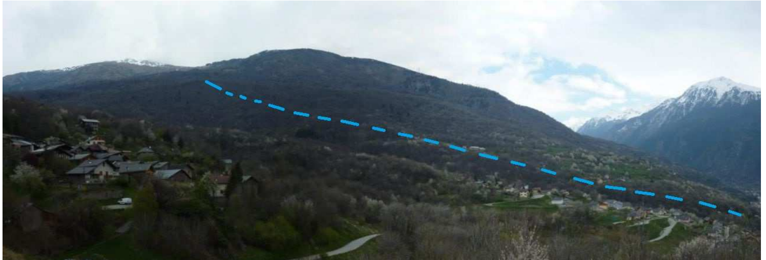
Illustration 11: Vue globale du site (prise de vue depuis le lieu dit "sur le Poingt")
