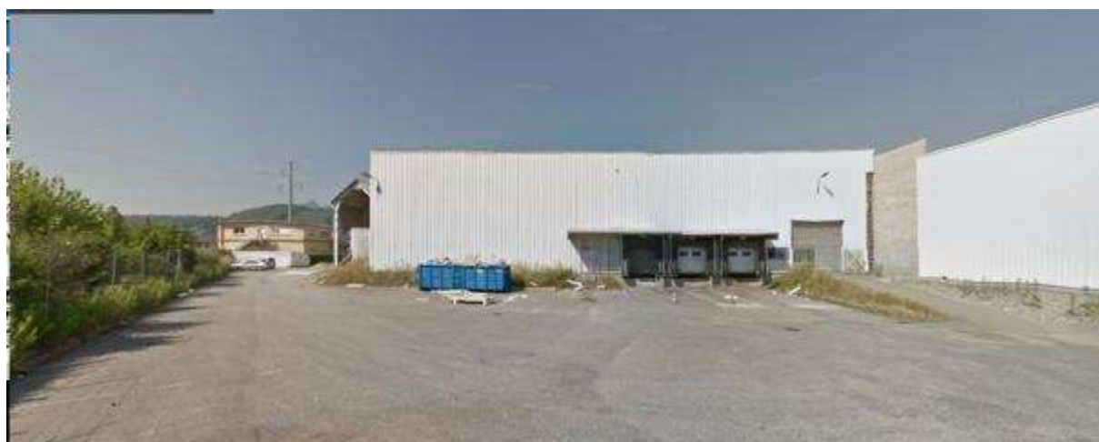
Prise de vue 2 : (façade Est) :
