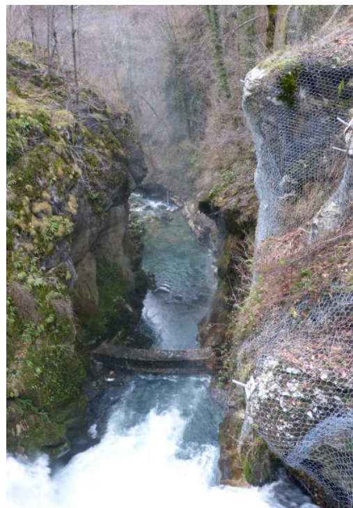
Figure 9: vue à l'aval immédiat du barrage
