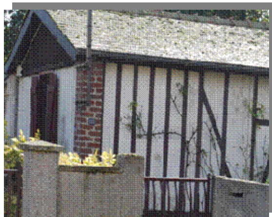
Figure 18 : Murs à ossature bois et remplissage en torchis ou moellon enduit (Source : CETE NC, INERIS)
