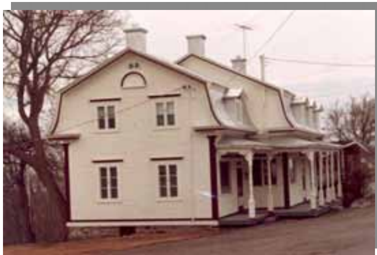
Figure 27 : Toiture à la Mansart (Source : Internet)
