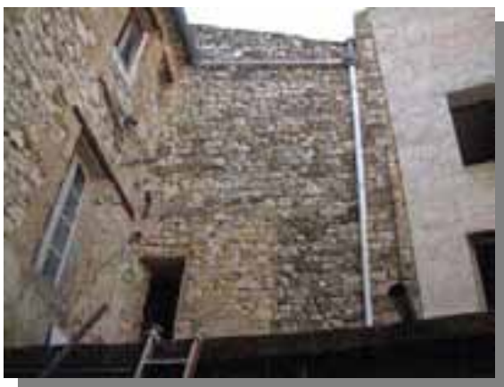
Figure 14 : Maçonneries en moellons (Source : CETE Méditerranée)
