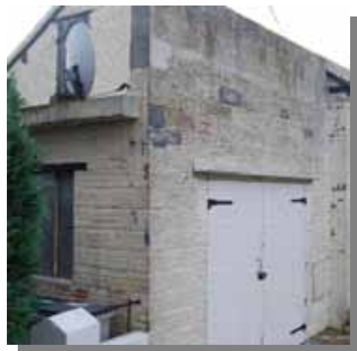
Figure 13 : Bâti en briques creuses de grande taille, recouvert d'enduit (Source : CETE NC, INERIS)
