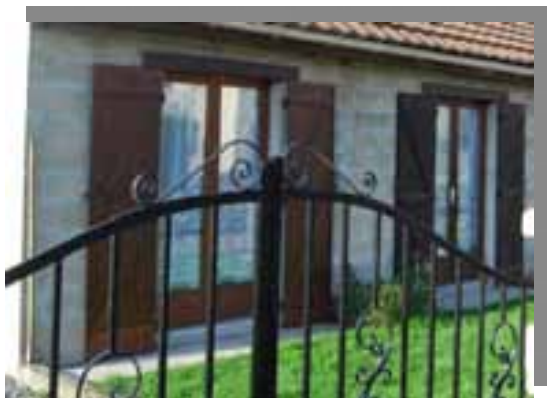
Figure 7 : Mur en parpaings sans enduit (Source : CETE NC, INERIS)
