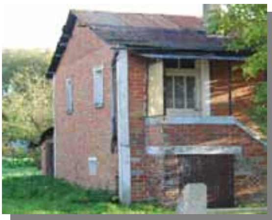
Figure 12 : Bâti en briques creuses de petite taille, non enduit et avec poteaux d'angles (petite partie maçonnée en briques pleines) (Source : CETE NC, INERIS)
