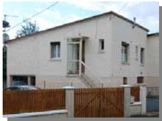
Figure 26 : Construction présentant une pente de toiture < 25^\circ (Source : CETE NC, INERIS)
