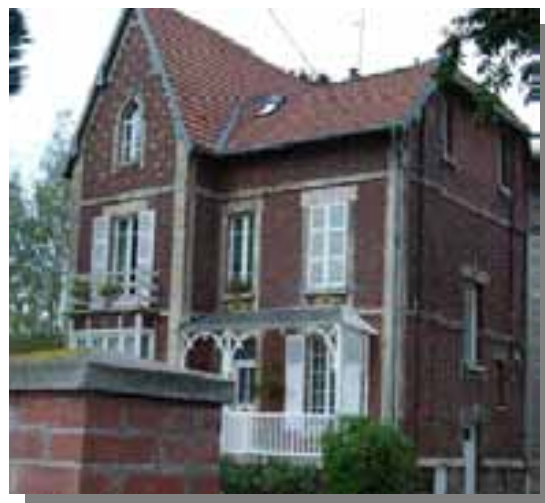
Figure 9 : Construction briques pleines, angles et niveaux de planchers mis en valeur avec des pierres (Source : CETE NC, INERIS)
