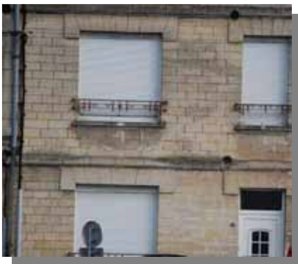
Figure 6 : Murs en pierres, blocs moyens (Source : CETE NC, INERIS)
