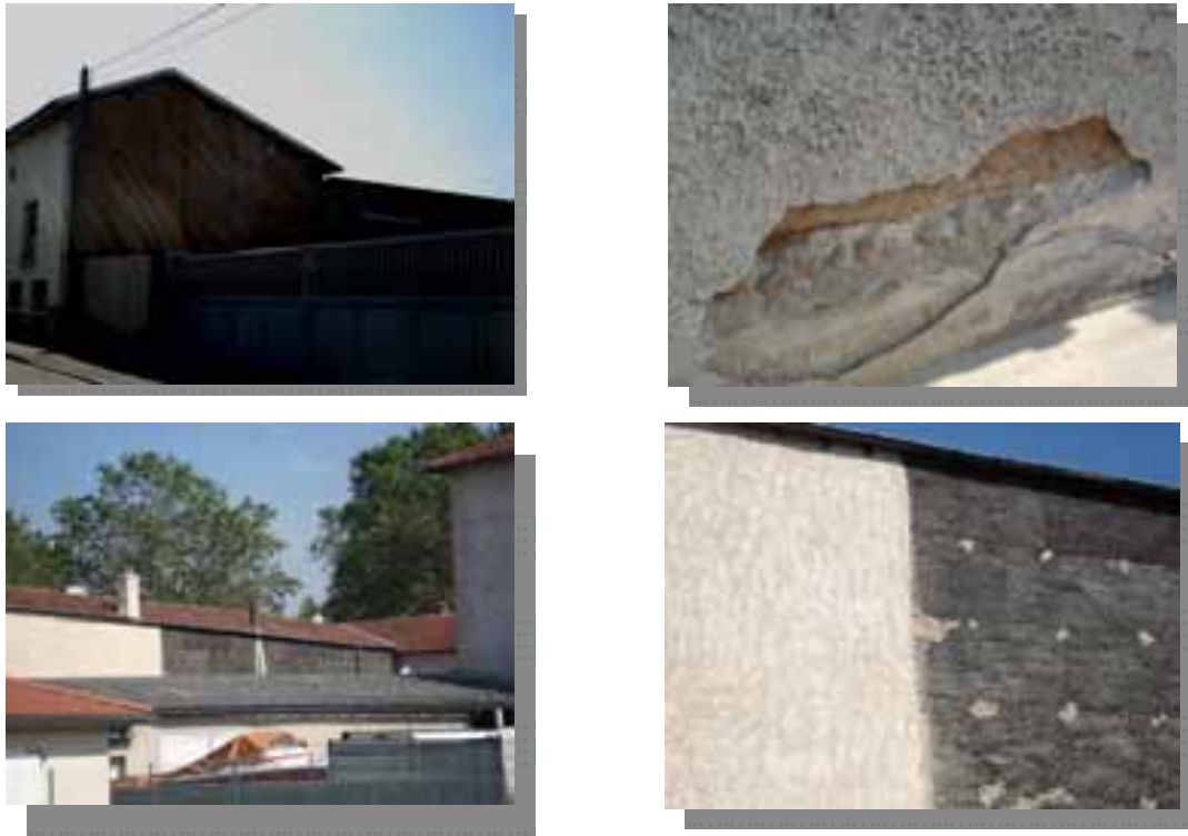
Figure 21 : Exemples de murs en pisé (Source : INERIS)
