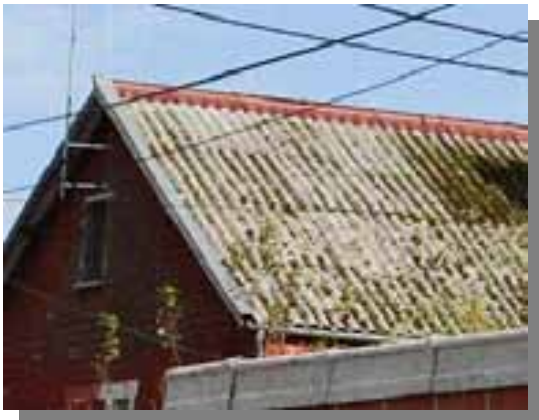
Figure 32 : Grands éléments de couverture : Plaques de fibro-ciment (Source : CETE NC, INERIS)
