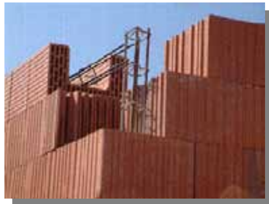
Figure 11 : Mur en briques creuses en cours de réalisation (Source : CETE Méditerranée)
