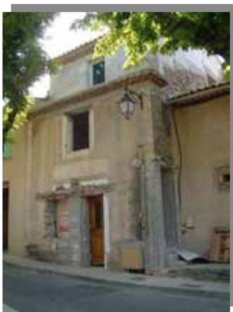
Figure 24 : Mur de façade mixtes (Source : CETE Méditerranée)
