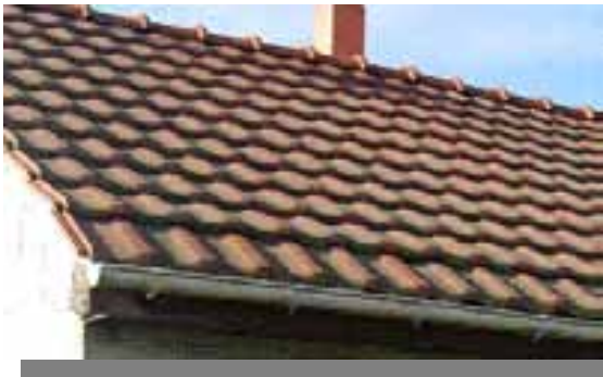
Figure 30 : Petits éléments de couverture : tuiles mécaniques terre-cuite ou béton (Source : CETE NC, INERIS)
