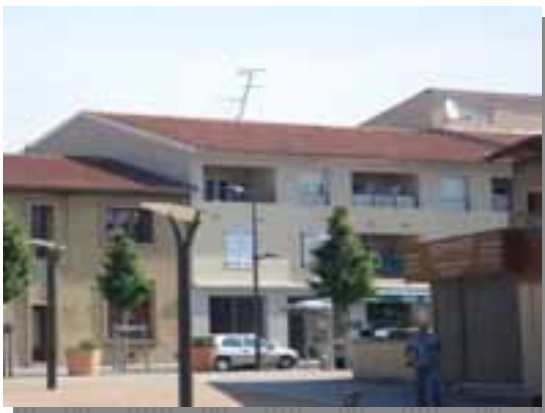
Figure 3 : Petit collectif en béton armé (Source : INERIS)
