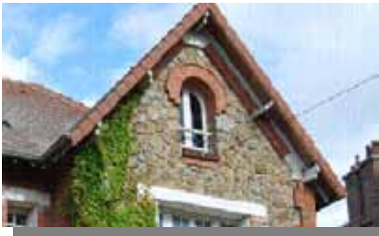
Figure 25 : Construction présentant une pente de toiture > 25^\circ (Source : CETE NC, INERIS)
