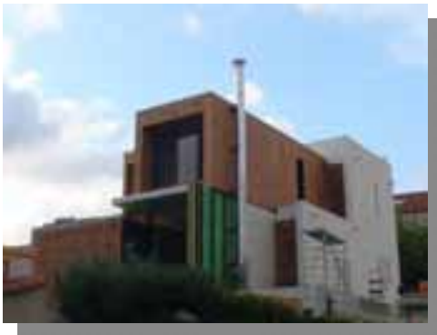
Figure 22 : Construction mixte ossature bois avec bardage en bois – béton armé (Source : CETE Méditerranée – J. SOLARI architecte)
