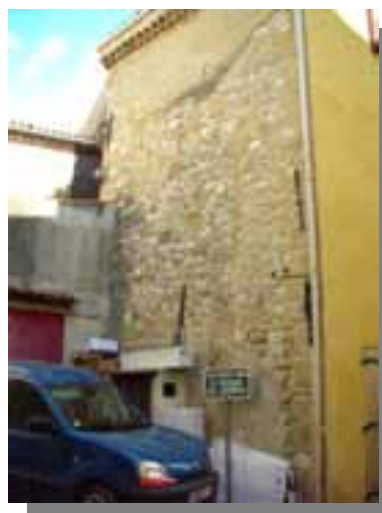
Figure 14 : Maçonneries en moellons (Source : CETE Méditerranée)
