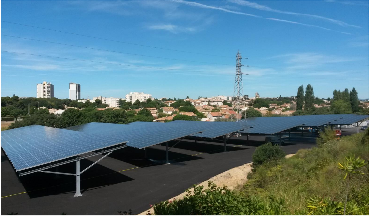
Vue du parking
