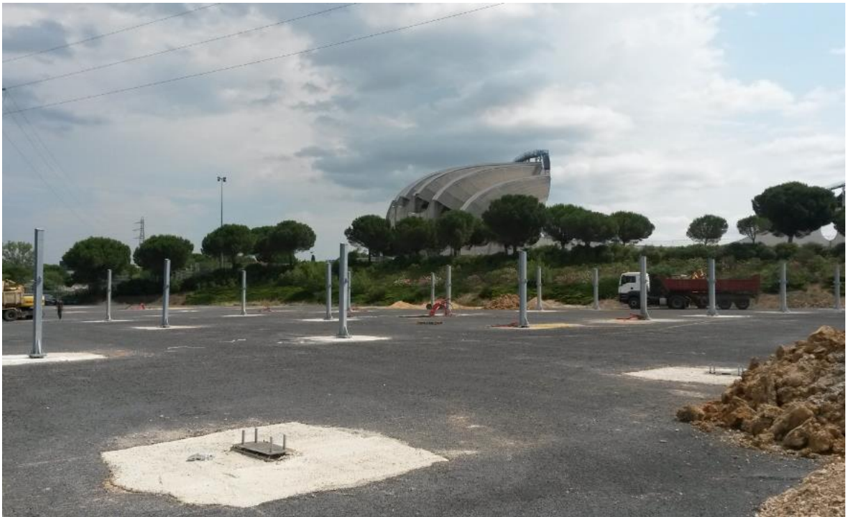
Coulage des fondations et pose des poteaux
