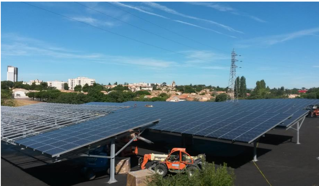
Pose des modules
