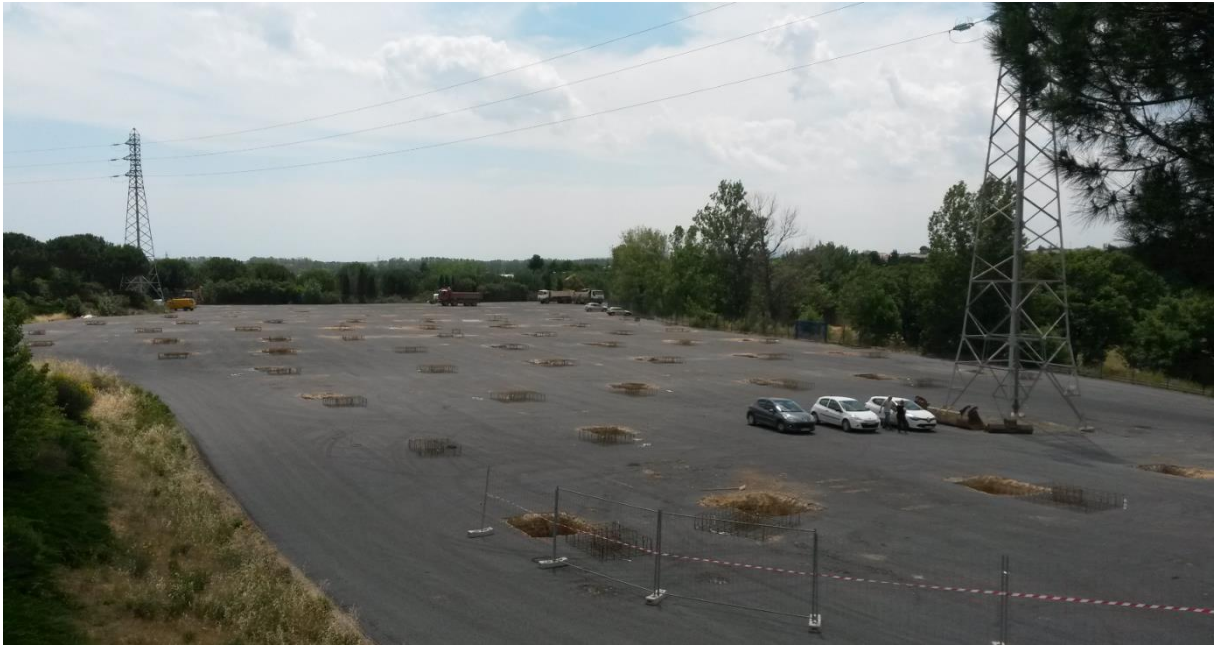
Creusement des fondations
