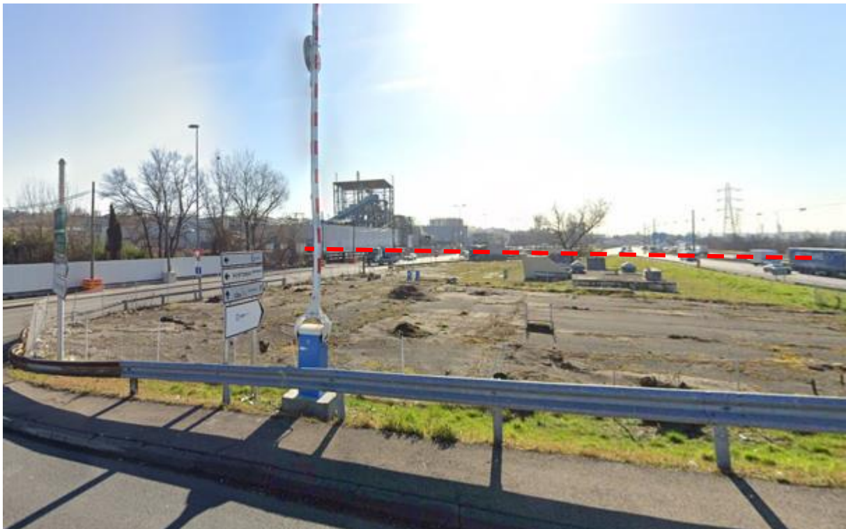
Photo 4 – Quai Louis Aulagné
