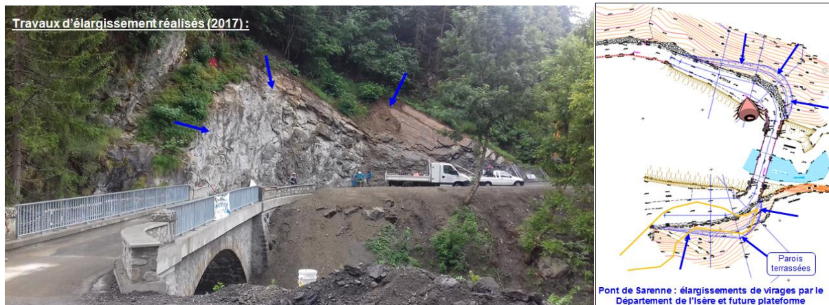
Figure 83 : Travaux d'élargissement de la RD 211a réalisés par le Département de l'Isère
