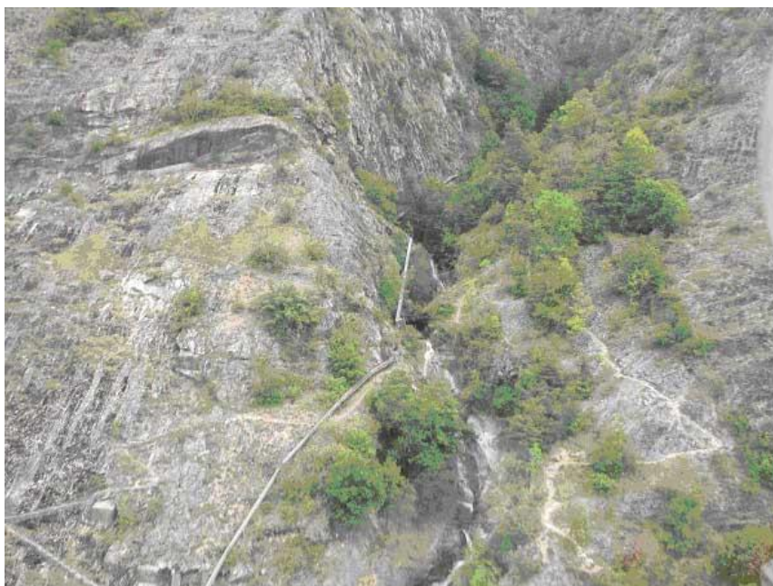
Figure 27 : Secteur aval Tronçon 4
