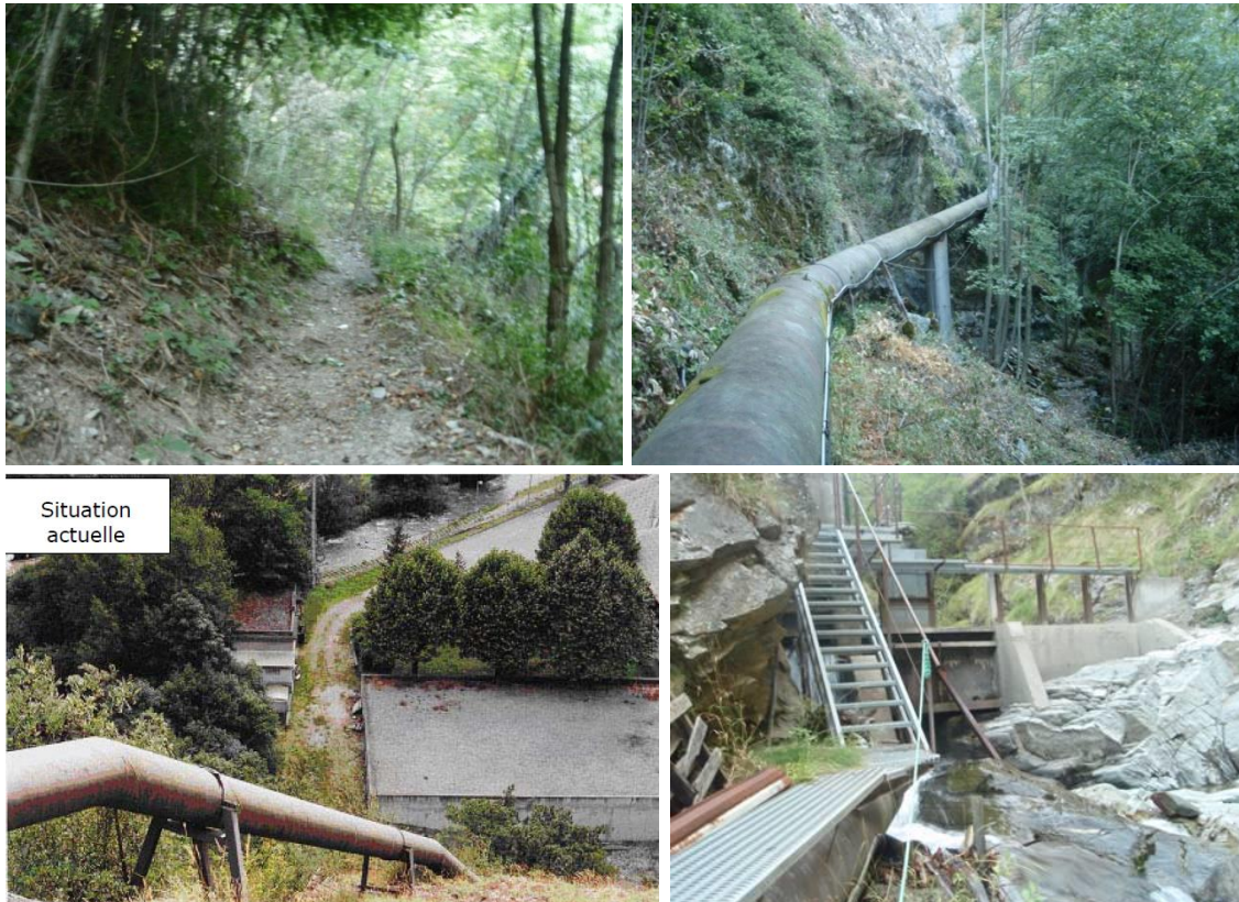
Figure 112 : Vues de l'ancien aménagement : piste d'accès, conduite, usine et prise d'eau
