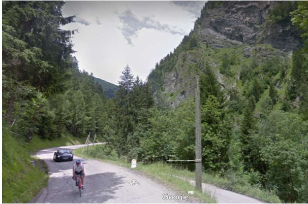
Vue depuis la RD 902 au droit de la voie d'accès vers la centrale – Direction Nord
