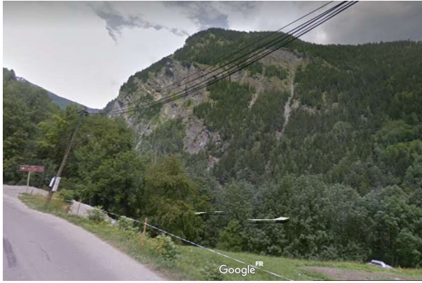
Vue depuis la RD 902 au droit de la ferme du Chatelard – Direction Nord
