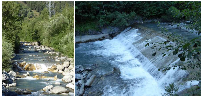
Figure 10 : Torrent du Versoyen, secteur aval, vue vers l'amont (à gauche). Seuil au lieu-dit de la Fabrique (à droite).
