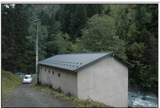
Centrale de Bonneval amont – Site de la prise d'eau
