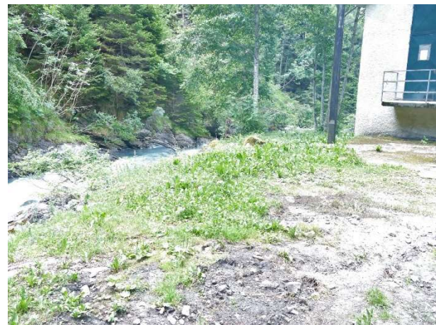
Abords de de la centrale de Bonneval
