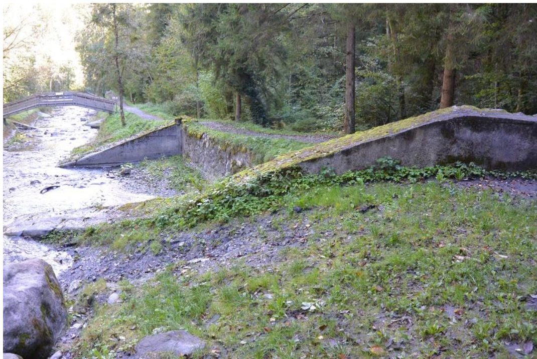
Photo 3 : digue RTM de rive droite, en aval de la cascade. La conduite sera enterrée à droite de cette digue. L'emprise sera masquée par le rideau d'arbres en pied de digue.
