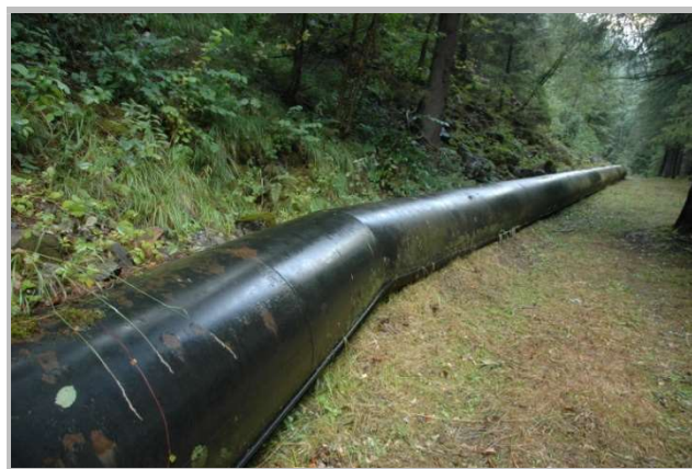
Photographie 6 – Partie finale de la conduite
