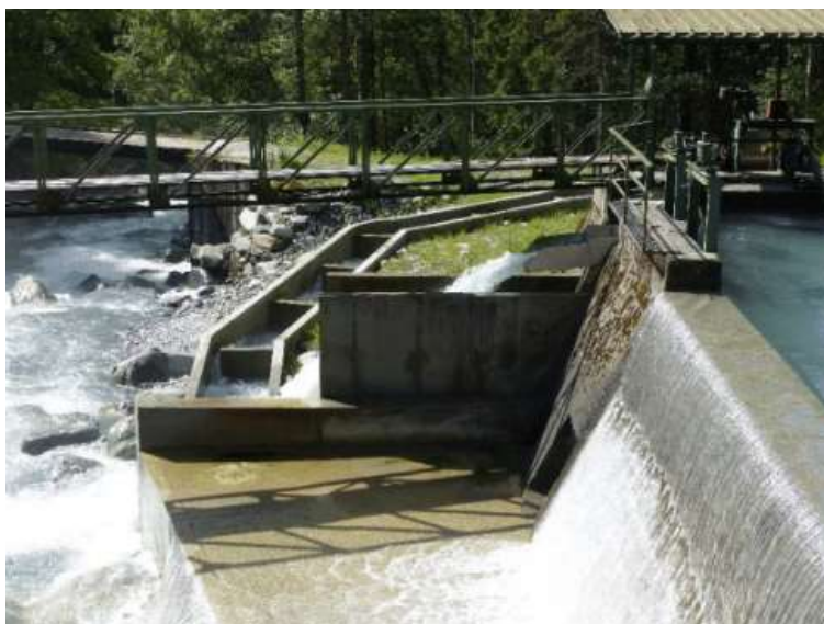
Photographie 3 – Passe à poissons centrale de Bonneval
