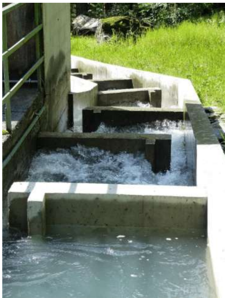
Photographie 4 – Passe à poissons centrale de Bonneval
