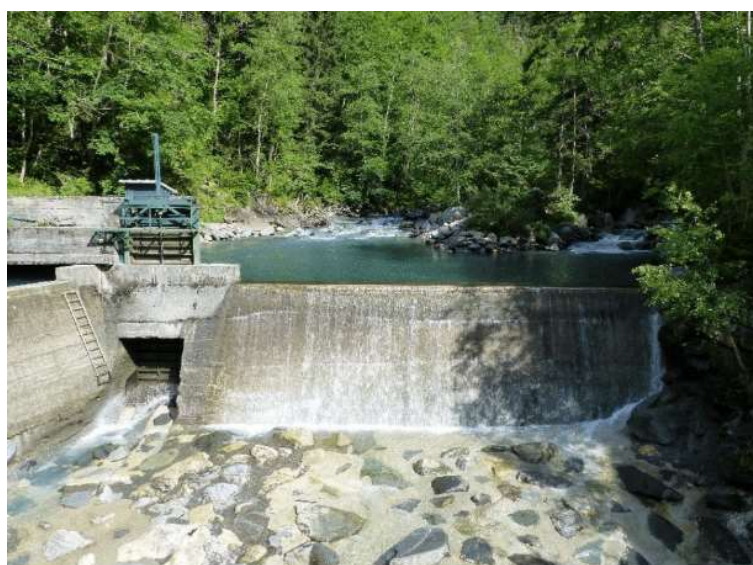
Photographie 2 –Seuil de la centrale de Bonneval vu de l'aval
