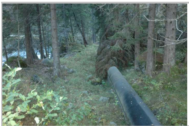
Photographie 5 – Partie initiale de la conduite proche du seuil
