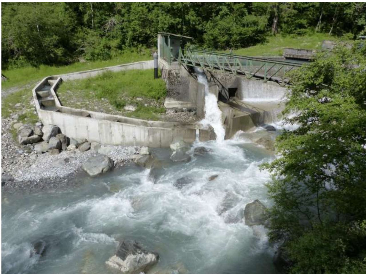
Photographie 1 – Passe à poissons – Seuil de la centrale de Bonneval
