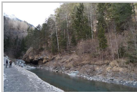
Photographie 17 – Zone de la centrale vue depuis la rive droite
