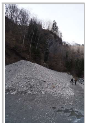
Photographie 13 – Tronçon final de la conduite – Zone de dépôt en rive droite avant traversée du Versoyen
