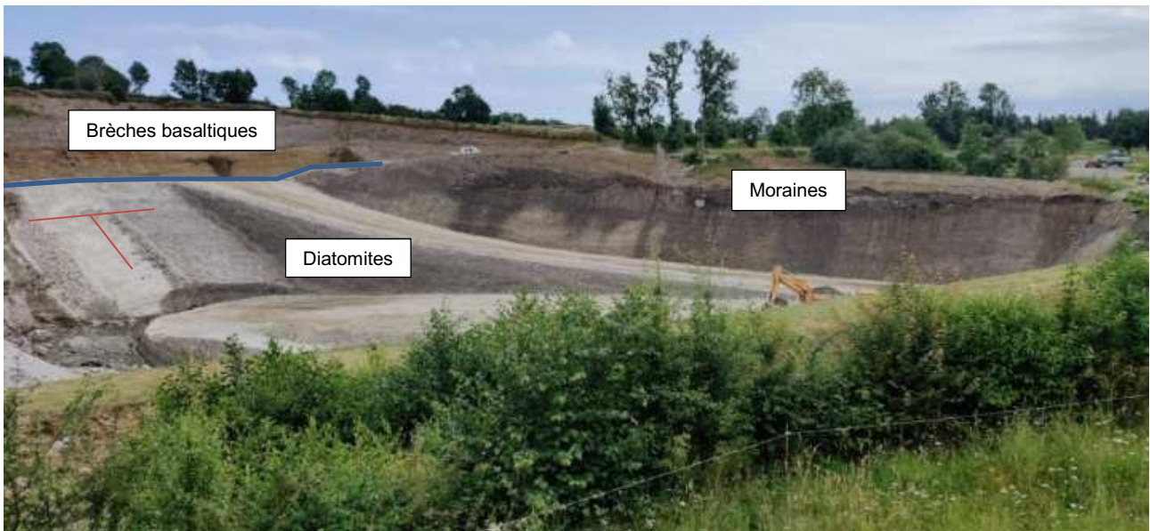
illustration 5 - Vue sur le mur des diatomites fortement redressé (T rouge)
