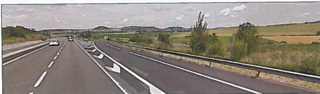
Figure 27 : En allant vers Clermont-Ferrand, le secteur Nord du projet d'aménagement, situé à droite de l'autoroute, est bien visible mais pendant une courte séquence et ce sont plutôt les silhouettes des puys, dans le lointain, qui s'imposent au regard.
