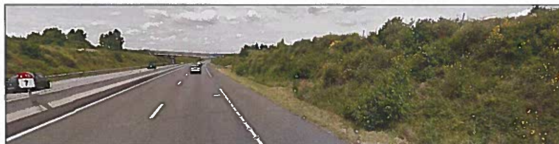
Figure 26 : En allant vers Clermont-Ferrand, avant le passage sous le pont de la RD 756, le secteur Sud est masqué par le talus de l'autoroute.
