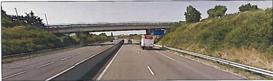
Figure 22 : En venant de Clermont-Ferrand, le franchissement de l'A75 par la RD 756 s'effectue sur une portion où l'autoroute est en tranchée, masquant ainsi le Parc d'Activités Économiques de La Novialle-Gergovie à la vue.
