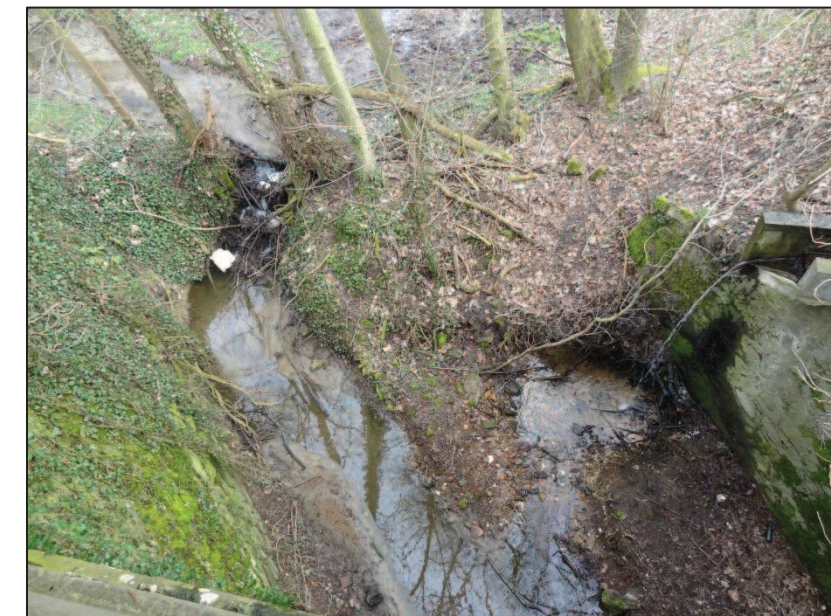
Photo 26 : Ruisseau de La Beffe Source : © Egis Environnement / D. FERREIRA, 2013.
