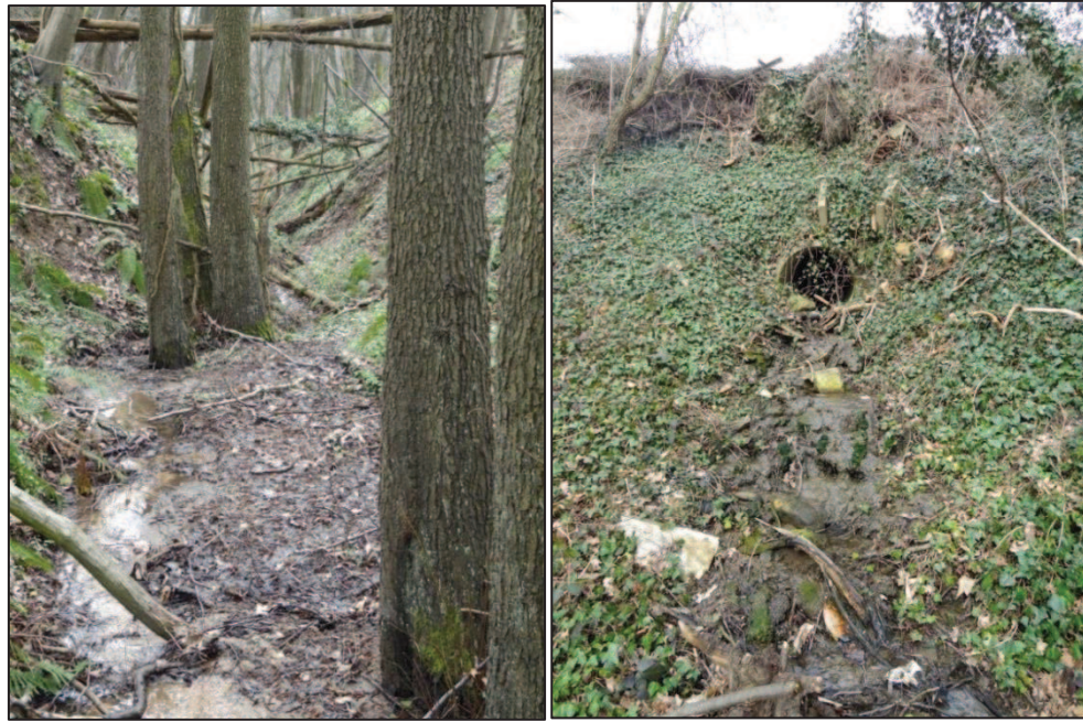
Photo 22 : Affluent rive droite du ruisseau du Sémanet au droit du Bois d'Ars. À gauche, vue sur l'écoulement. À droite, ouvrage de rétablissement hydraulique sous l'A6 Source : © Egis Environnement / D. FERREIRA, 2013.
