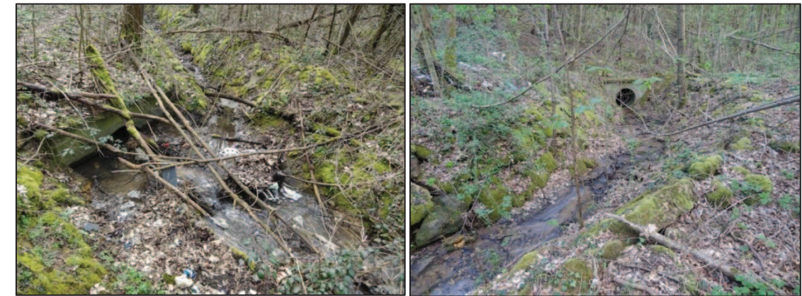
Photo 20 : Talweg du Bois des Longes rétabli sous la RN489. À gauche : ouvrage hydraulique amont, à droite : ouvrage hydraulique aval. Source : © Egis Environnement / D. FERREIRA – P. BLANC, 2013.
