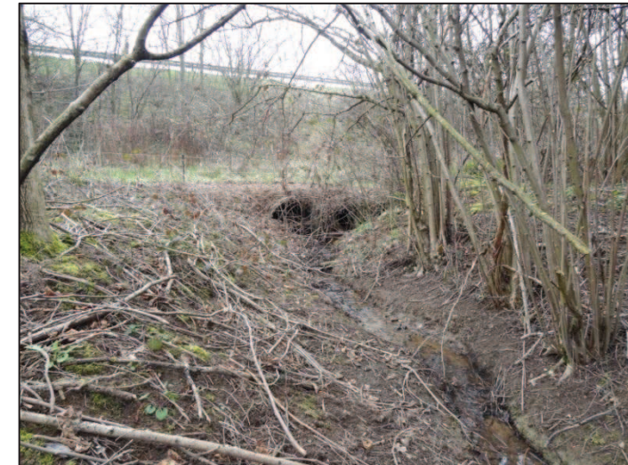
Photo 17 : Talweg formé entre la RN7 et le golf de La Tour-de-Salvagny (talweg 1). Source : © Egis Environnement / D. FERREIRA, 2013.
