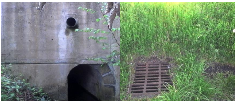
Réseau pluvial existant
