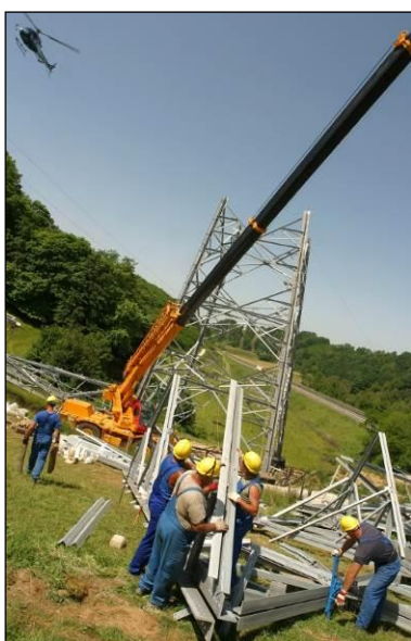
Assemblage au sol © RTE, 2013
