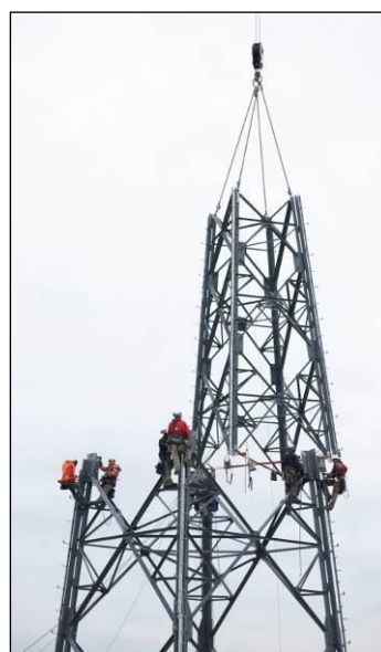
Levage à l'aide d'une grue © RTE, 2013
