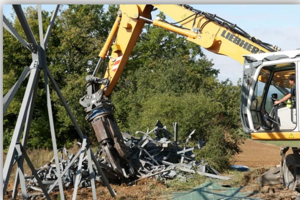
Découpage avec une cisaille hydraulique sur pelle mécanique d'un pylône en bord de parcelle © RTE, 2013
