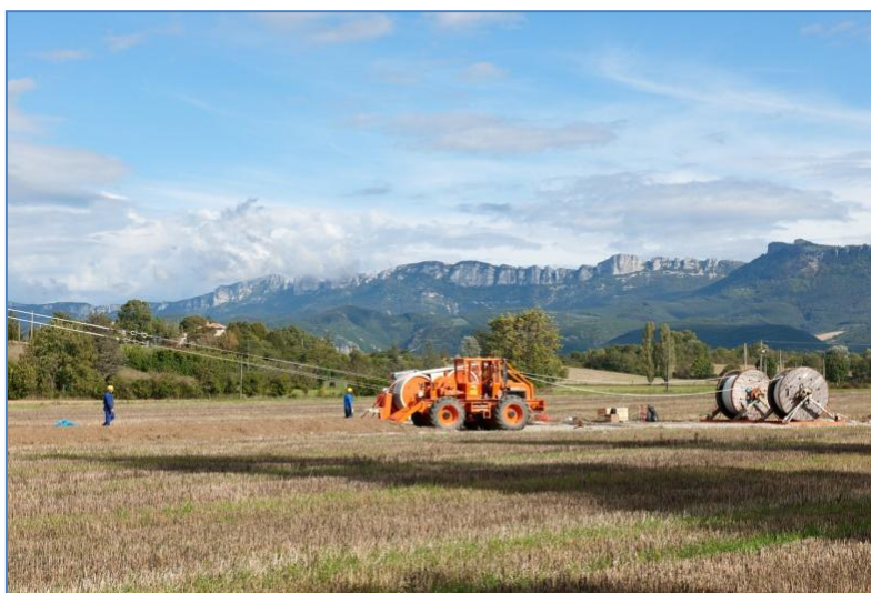
Déroulage des câbles © RTE, 2013
