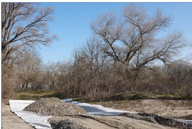
Piste provisoire en cours de réalisation avec pose de géotextile et apport de matériaux © RTE, 2013
