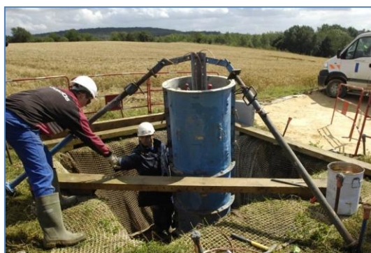
Fondations d'un pylône © RTE, 2013
