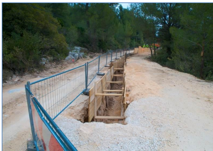
Pose en fourreau PEHD © RTE, 2013
