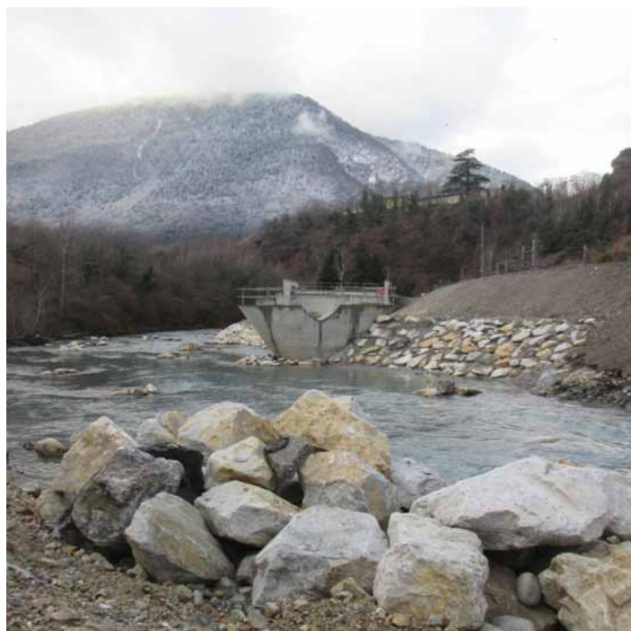
Les appuis des deux viaducs bientôt finalisés
