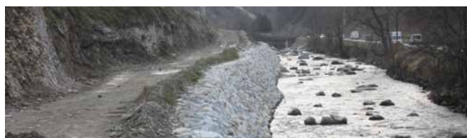
Des enrochements en rive gauche de l'Isère
