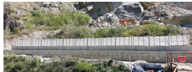
Dispositif de sécurisation de la zone de l'éboulement
