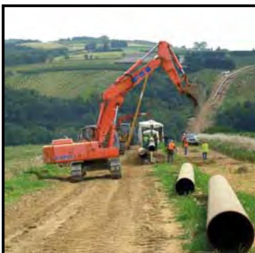
Pose de canalisation et transport de gaz naturel à haute pression entre Serpaize et Les Haies.
