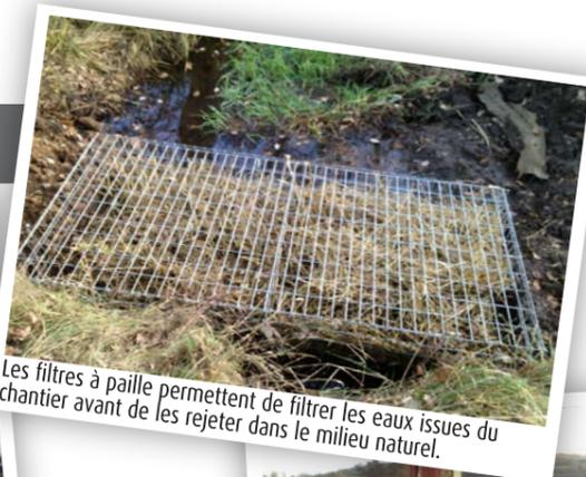
Les filtres à paille permettent de filtrer les eaux issues du chantier avant de les rejeter dans le milieu naturel.
