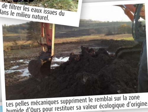
Les pelles mécaniques suppriment le remblai sur la zone humide d'Ours pour restituer sa valeur écologique d'origine.
