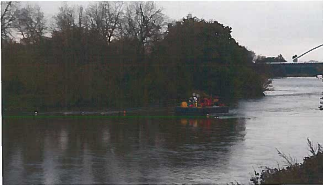
Figure 1-6. Photographie d'une barge de forage en opération sur la Loire
