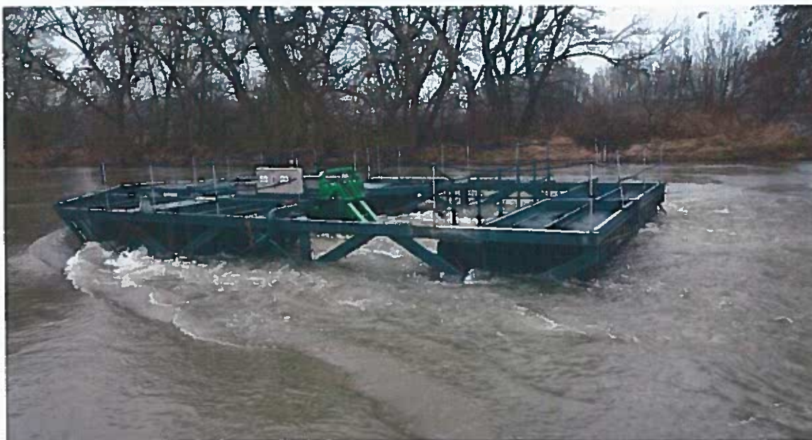
Figure 1-13. Hydrolenne HYDROQUEST RIVER 1.40 sur son site d'exploitation, en fonctionnement
