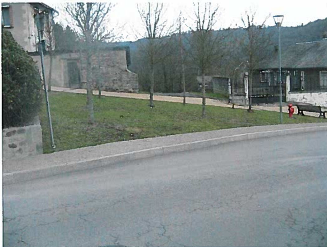
Photo 7 : Vue aménagement urbain (implantation station de pompage du foirail) Prise de vue parking du foirail –ville de Bort les Orgues
