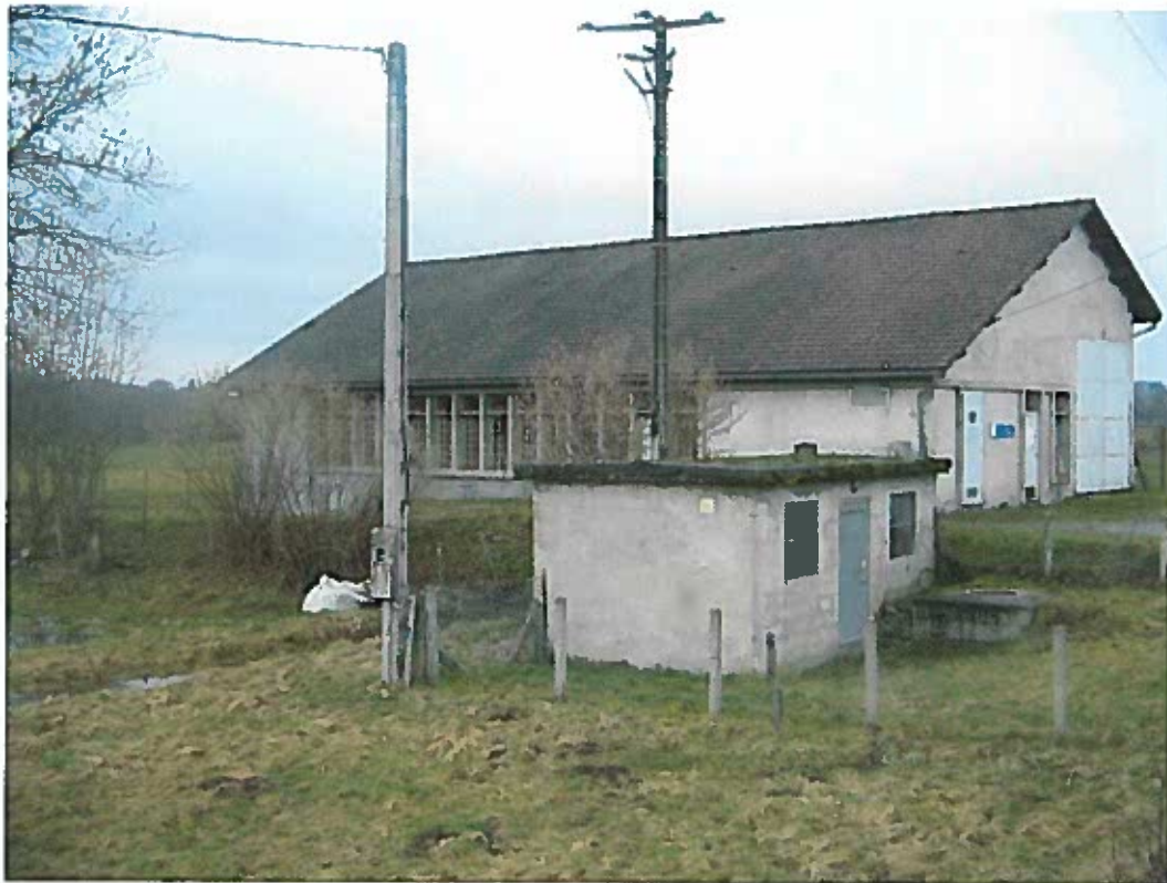
Photo 4 : Vue Station de Couchal (F3 est à l'arrière du bâtiment) Prise de vue RD415 – Champagnadoux – commune de Vebret
