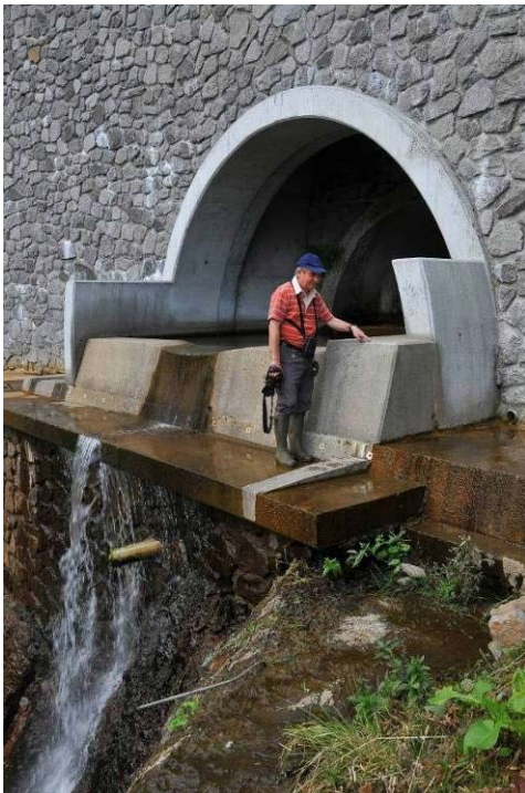
Le passage busé sous la route de Font de Cère, au Lioran, une épreinte de loutre découverte sur le mur aval. Une marche supplémentaire cubique de 30 à 50 cm de côté, ici aux pieds de C. Bouchardy, pourrait être ajoutée afin de faciliter le franchissement par la loutre. Puy de Dôme, France
