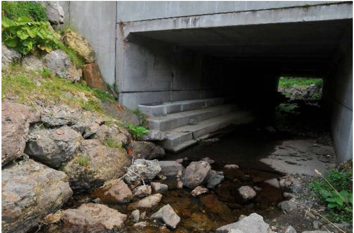
Le passage traditionnel à trois marches en rive gauche de l'Alagnon sous la N 122 au Lioran, 41174 Font de Cère, Lioran, Puy de Dôme, France
