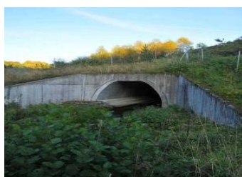
Le passage à loutres de l'Eau du Bourg sous l'A89, et une épreinte de loutre.
