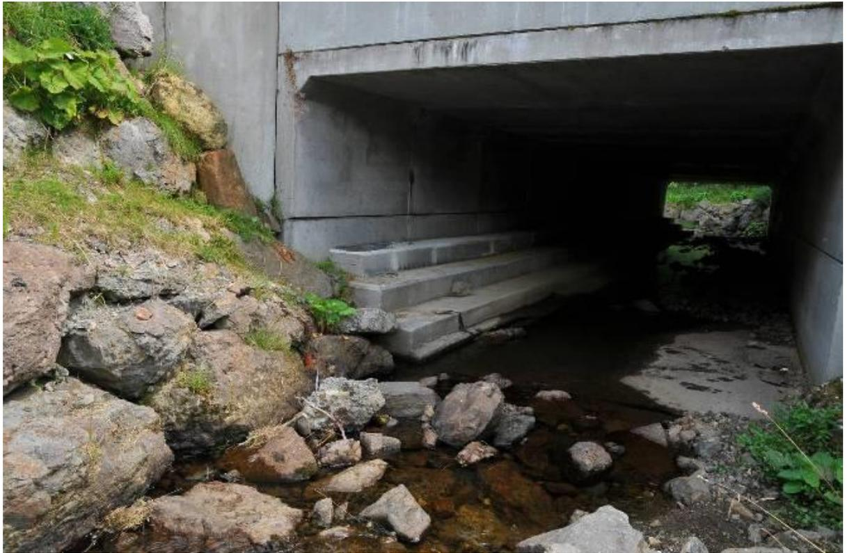
Le passage traditionnel à trois marches en rive gauche de l'Alagnon sous la N 122 au Lioran, utilisé par la loutre. Photos C. Lemarchand.
