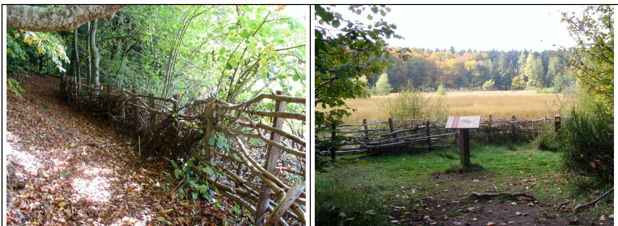
Barrières végétales installées en 2005
